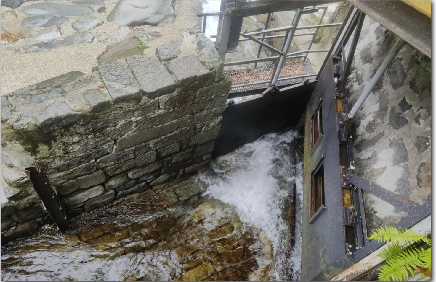
05 - Paratoia di regolazione per il rilascio del DMV
