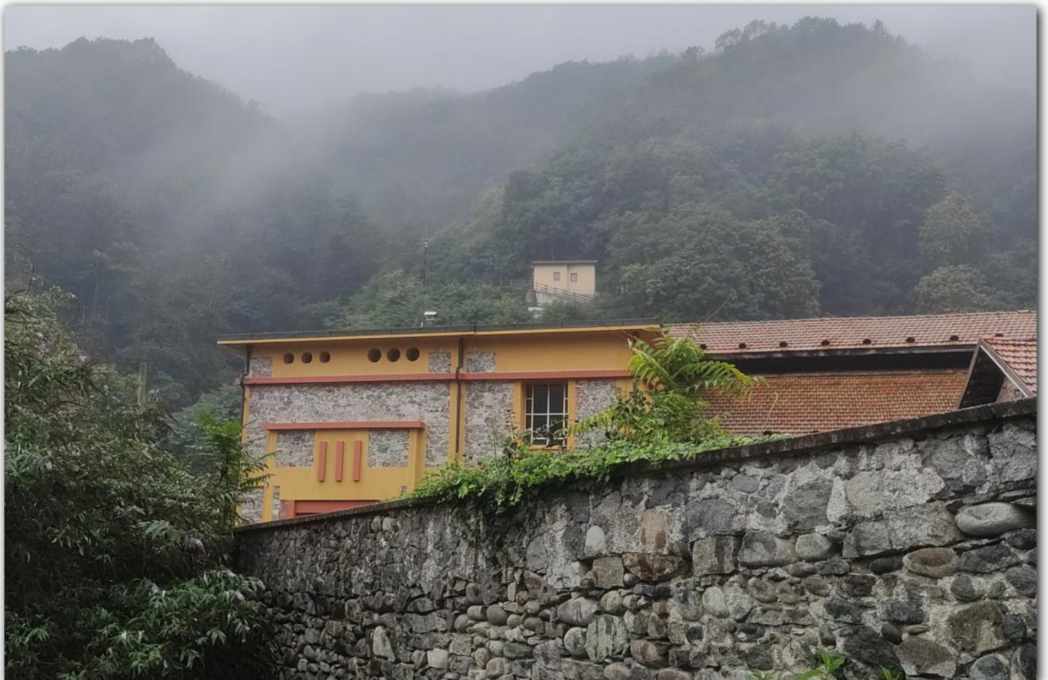
10 - Edificio di centrale e sullo sfondo locale della vasca di carico
