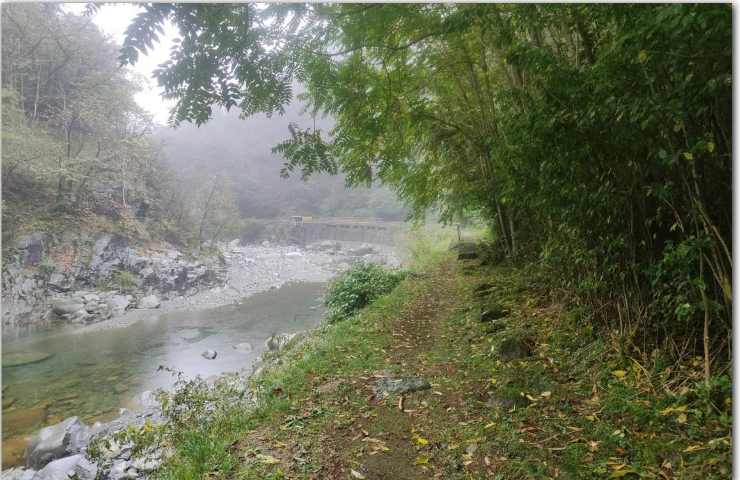
06 - Primo tratto canale di derivazione
