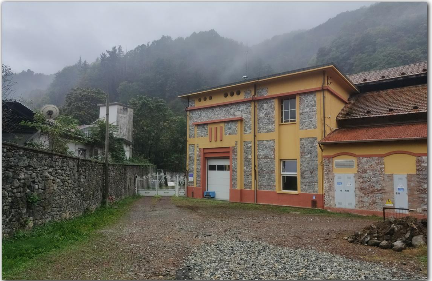
09 - Edificio di centrale
