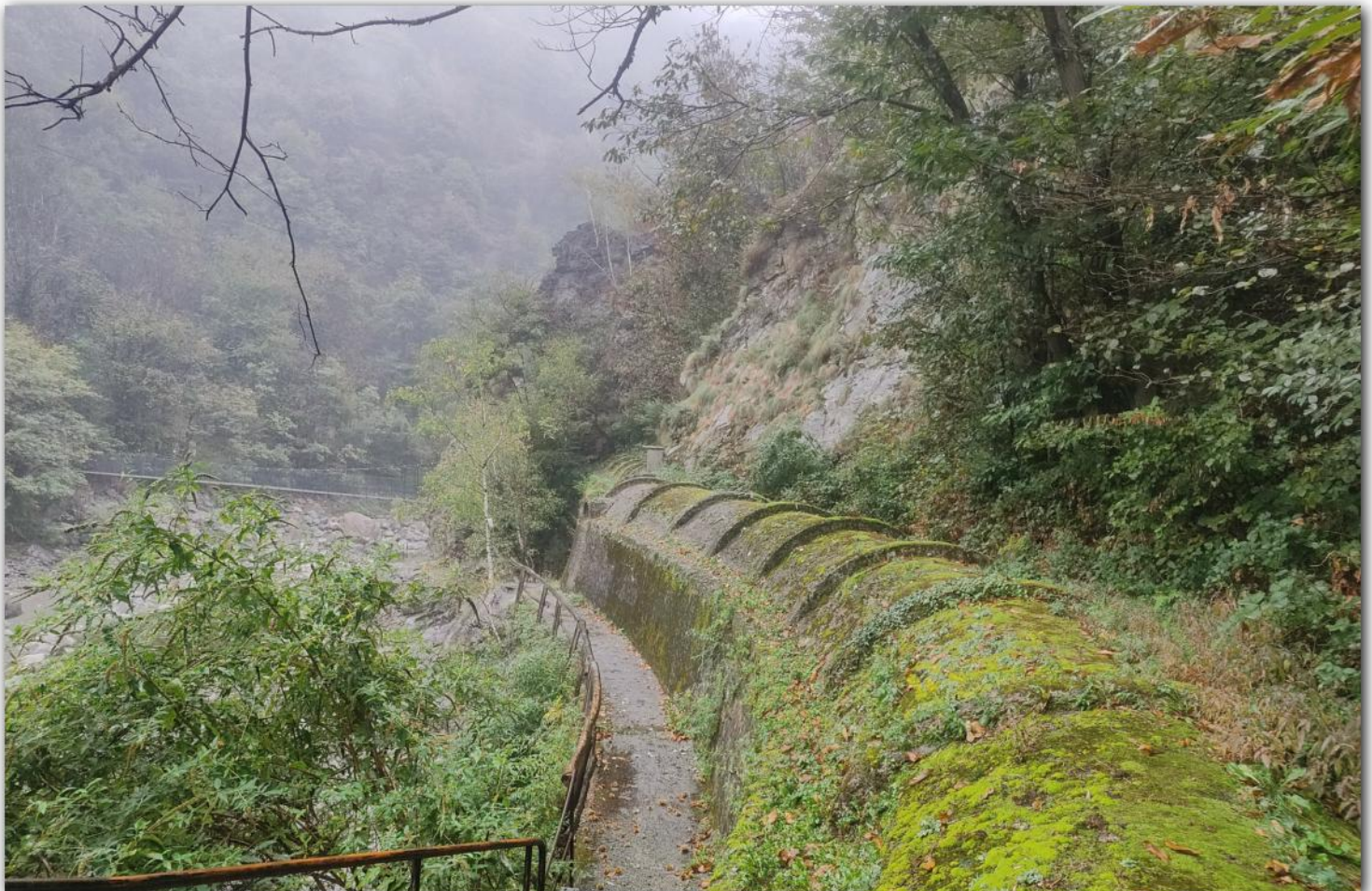
08 - Canale di derivazione, tratto prima di entrare in galleria
