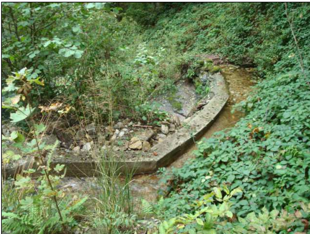
Fig. 11 - Vista attuale della parte terminale del cordolo con il pozzetto di imbocco: la tubazione che scende verso la vasca non è più visibile
