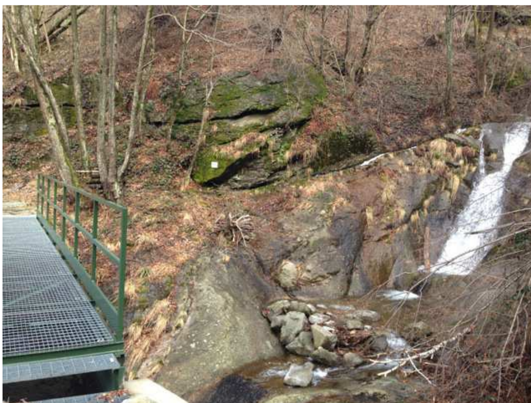
Fig. 5 - Vista frontale del canaletto inciso nel versante che collega la presa sul rio Grande al canale di carico dell'impianto
