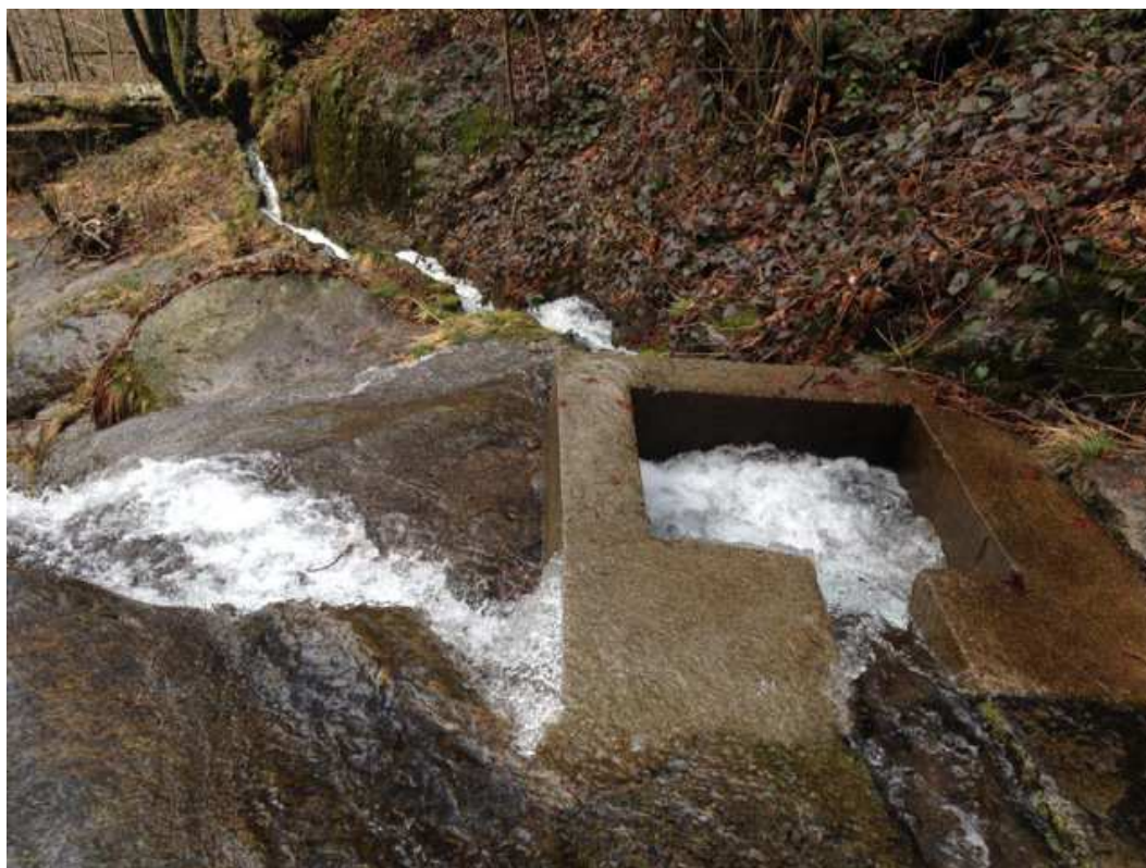
Fig. 4 - In primo piano il pozzetto in calcestruzzo dal quale parte - al centro della foto - il canaletto scavato nel versante che porta l'acqua al sottostante canale di adduzione dell'impianto
