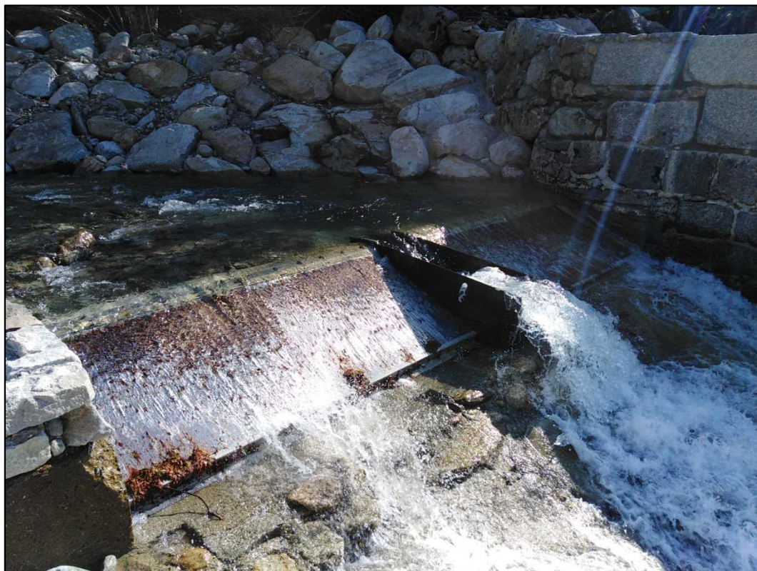
Fig. 1 - Configurazione attuale della presa sul torrente Oropa
