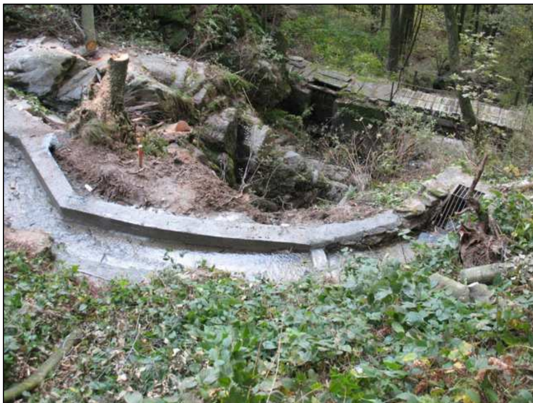
Fig. 9 - Vista della parte terminale del cordolo e dell'imbocco della tubazione
