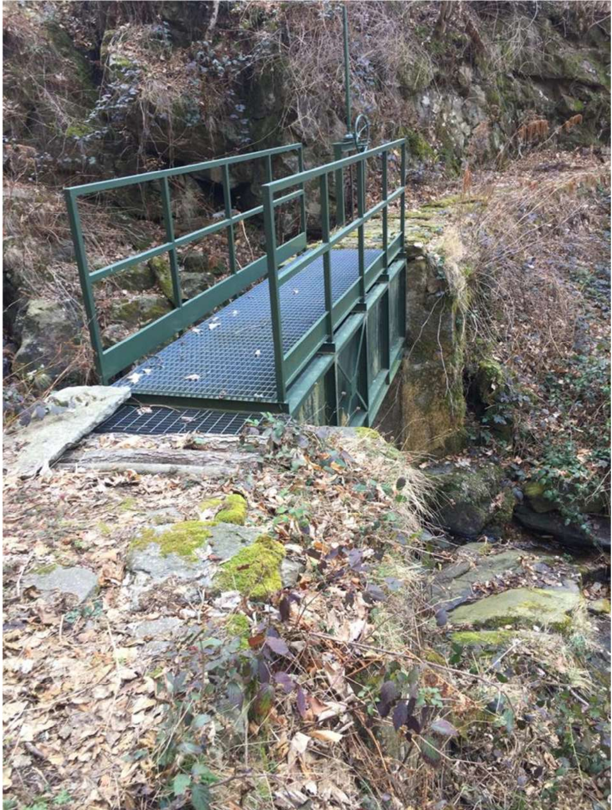
Fig. 12 – Vista d'insieme del ponte-canale sul rio Moscarola
