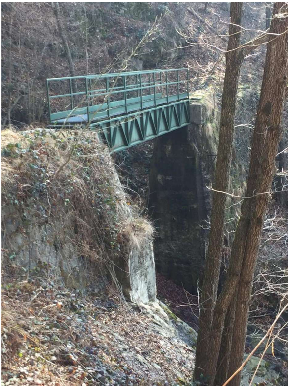
Fig. 9 – Vista della spalla in sinistra orografica del ponte-canale sul rio Grande
