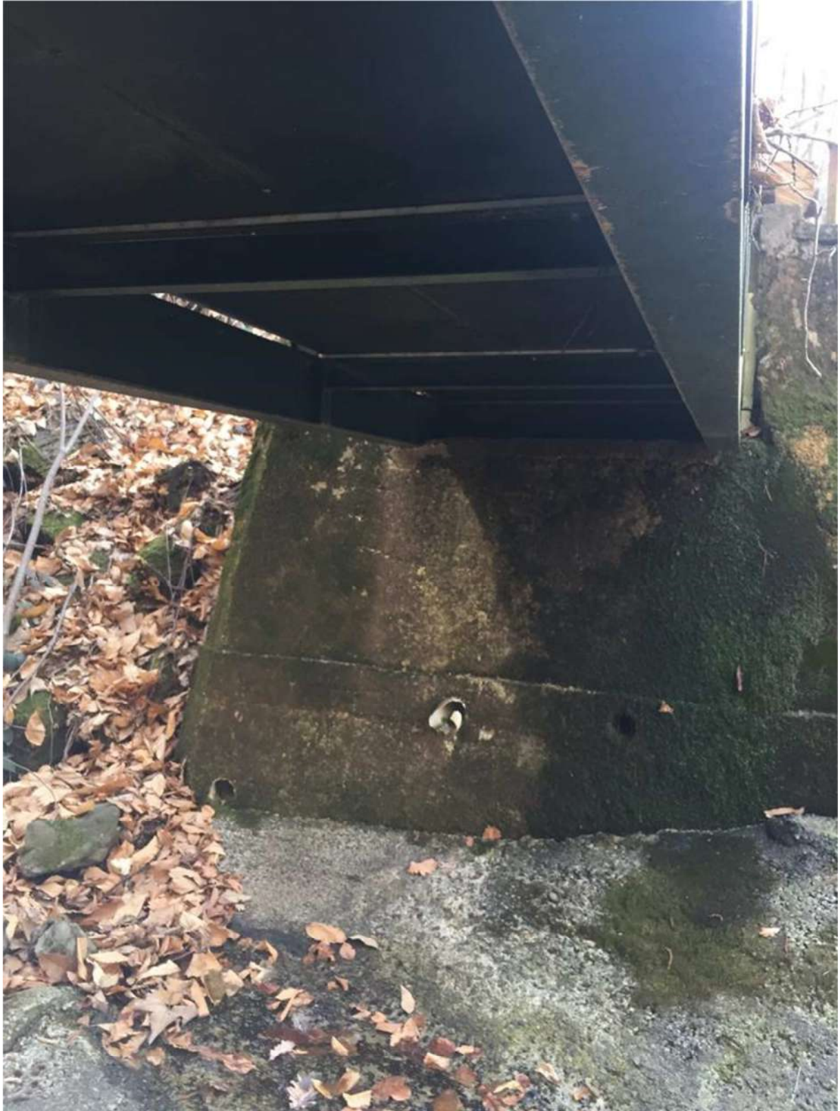
Fig. 17 – Vista della spalla in sinistra orografica del ponte-canale sul rio Neggia
