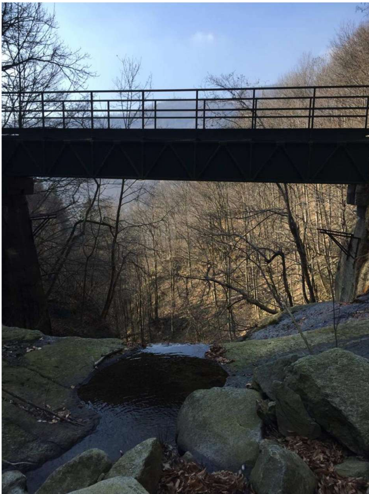
Fig. 10 – Vista da monte del ponte-canale sul rio Grande
