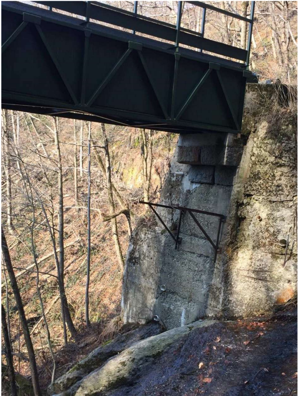
Fig. 11 – Vista della spalla in destra orografica del ponte-canale sul rio Grande
