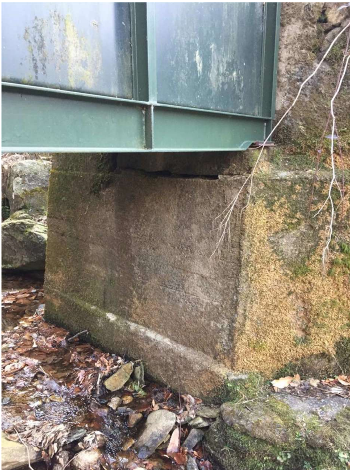
Fig. 14 – Vista della spalla in sinistra orografica del ponte-canale sul rio Moscarola
