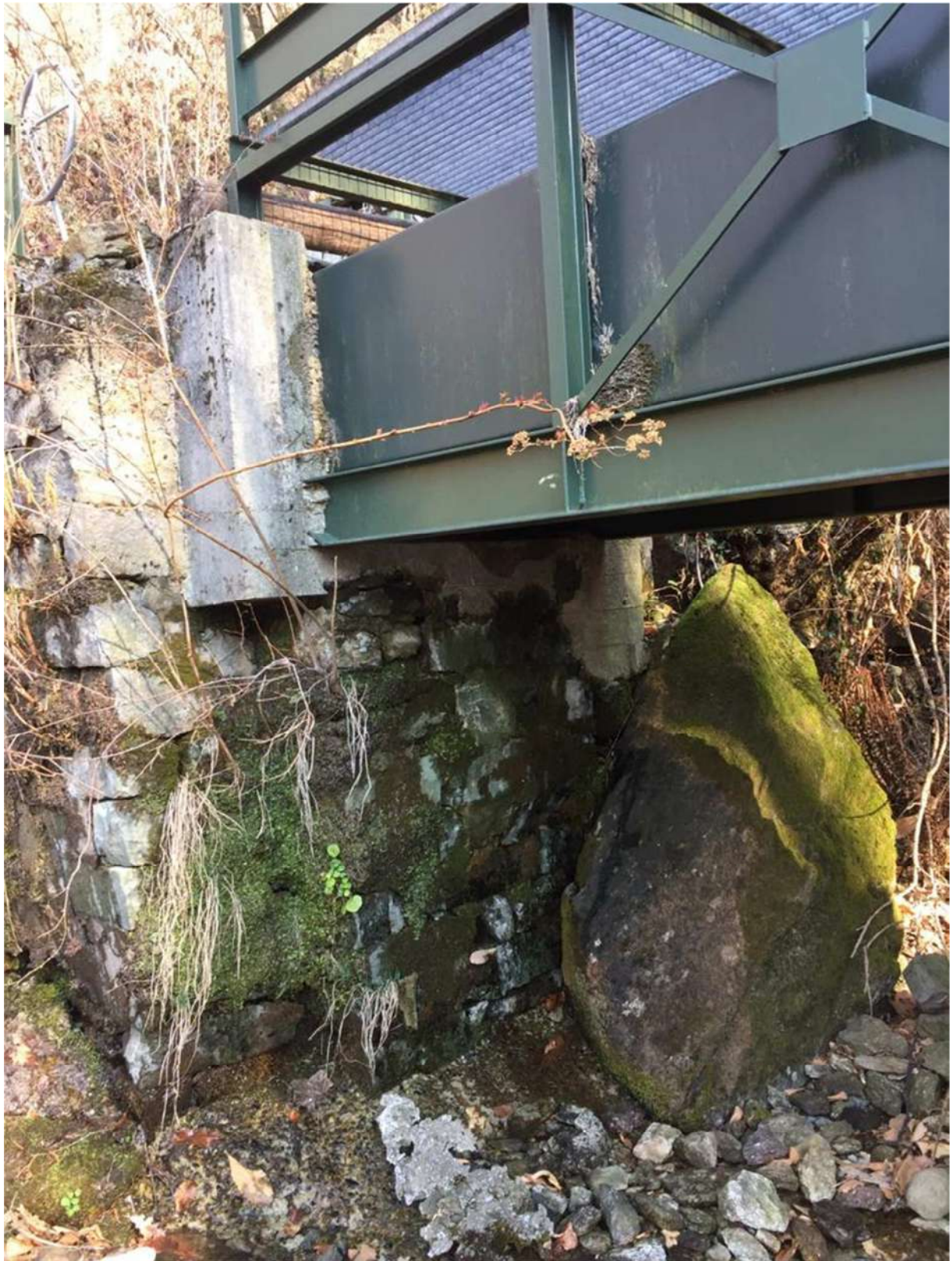
Fig. 16 – Vista della spalla in destra orografica del ponte-canale sul rio Neggia
