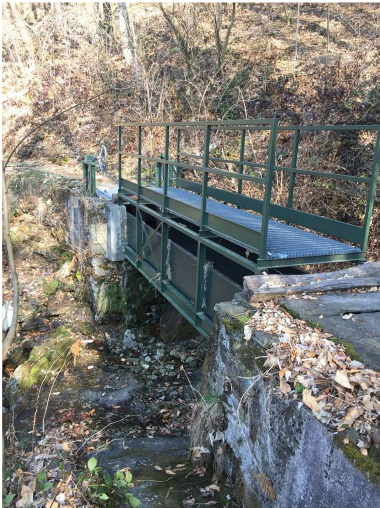
Fig. 15 – Vista d'insieme del ponte-canale sul rio Neggia
