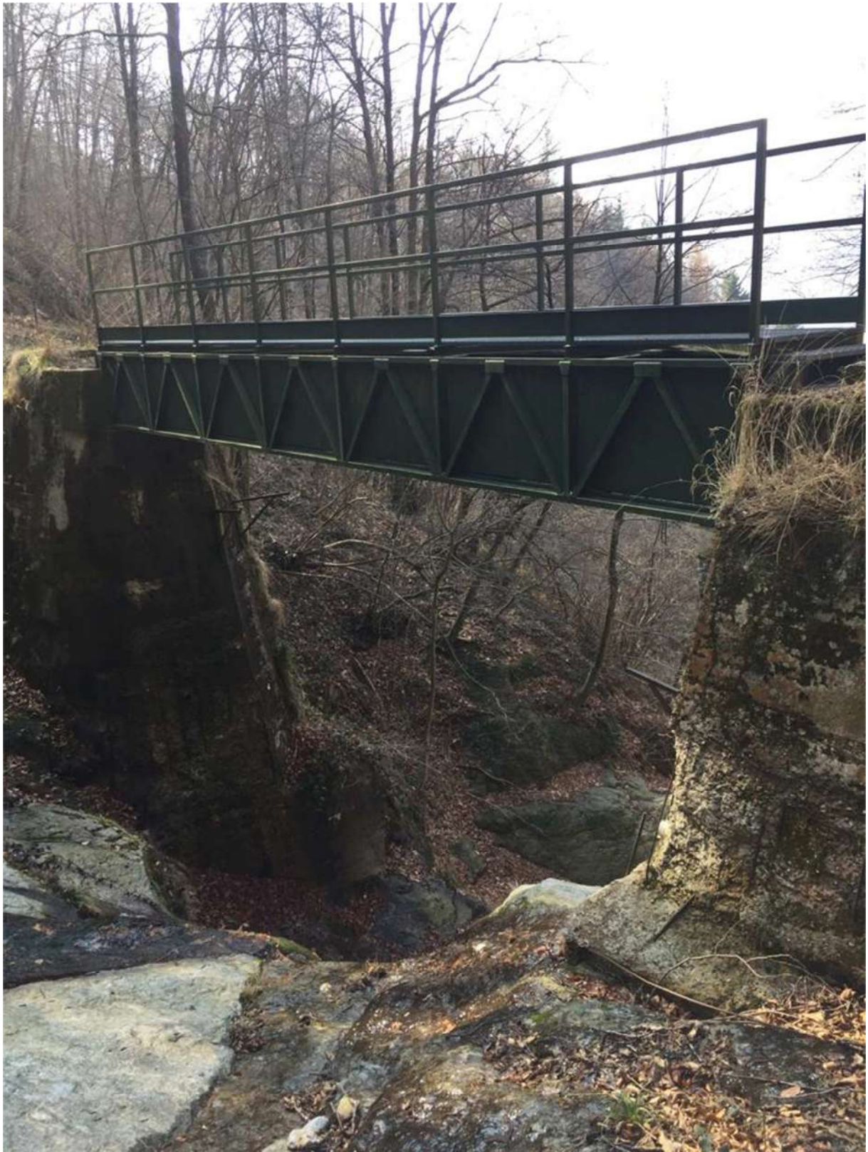
Fig. 8 – Vista d'insieme del ponte-canale sul rio Grande
