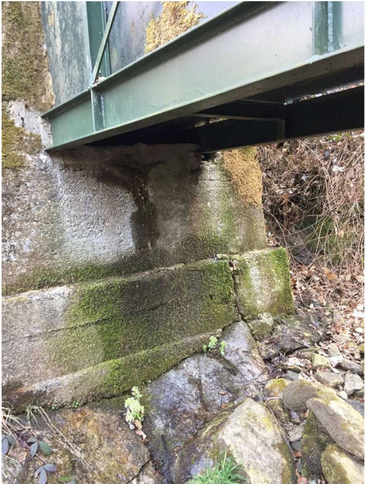
Fig. 13 – Vista della spalla in destra orografica del ponte-canale sul rio Moscarola
