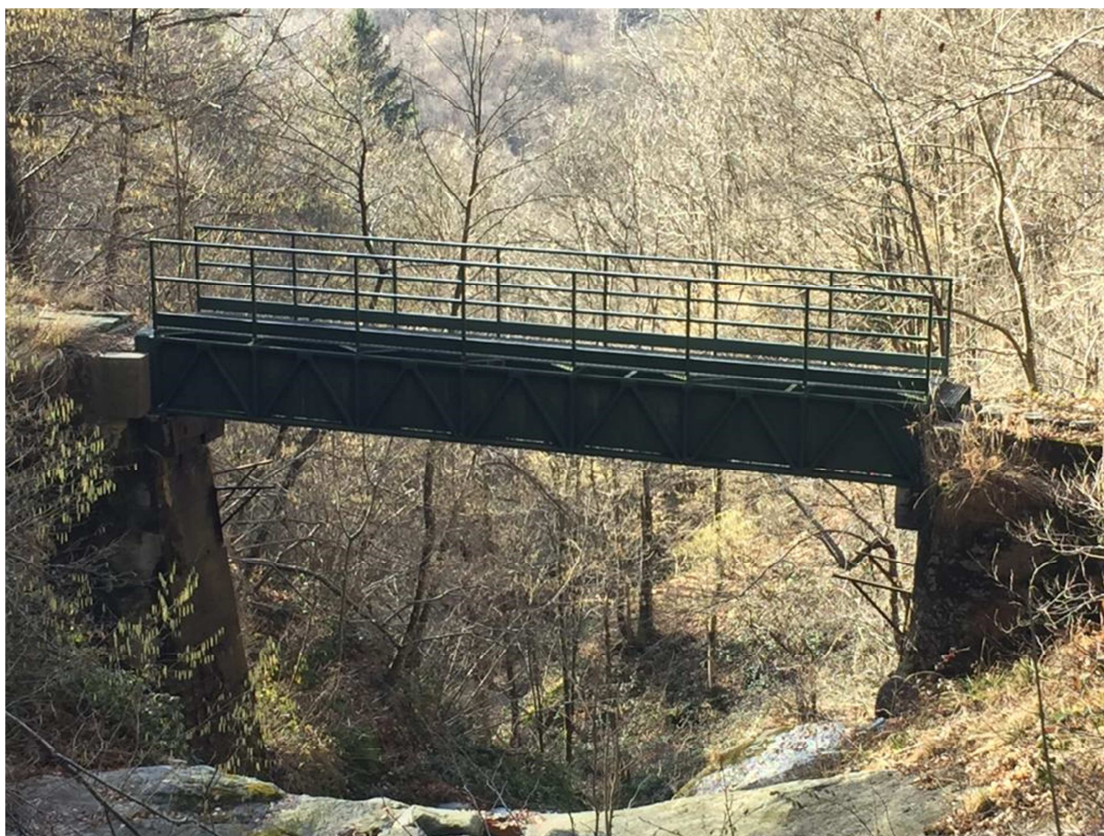
Fig. 4 – Ponte canale per l'attraversamento del rio Grande
