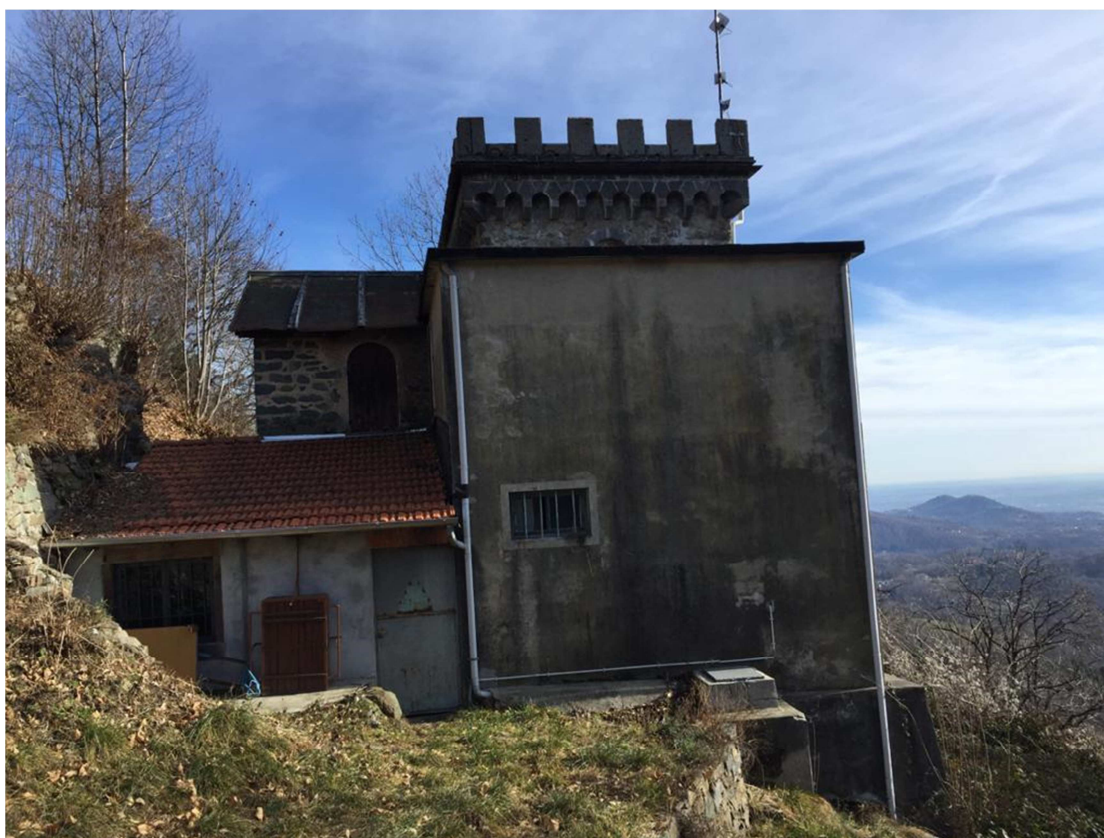
Fig. 6 – Il fabbricato che ospita la vasca di carico dell’impianto dalla quale partono le condotte forzate
