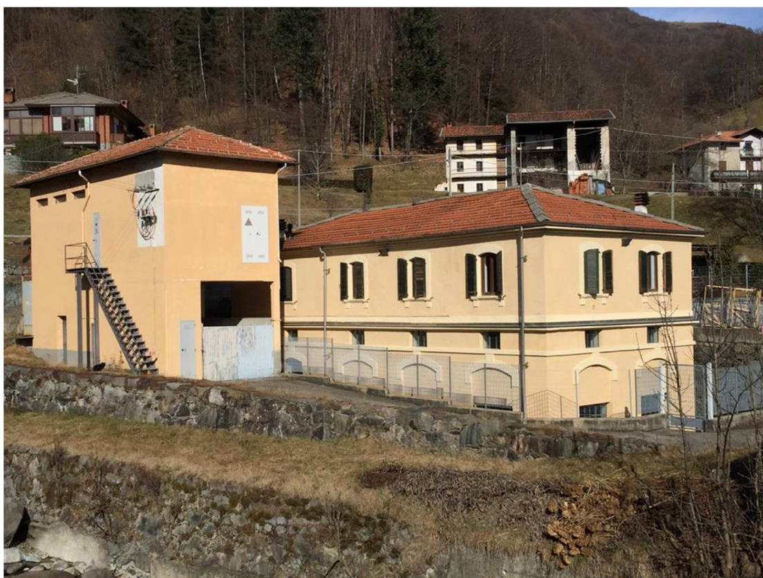
Fig. 7 – L'edificio che ospita la centrale (al piano interrato) e l'alloggio del custode al piano terra. A fianco, la cabina di consegna ENEL posta al primo piano
