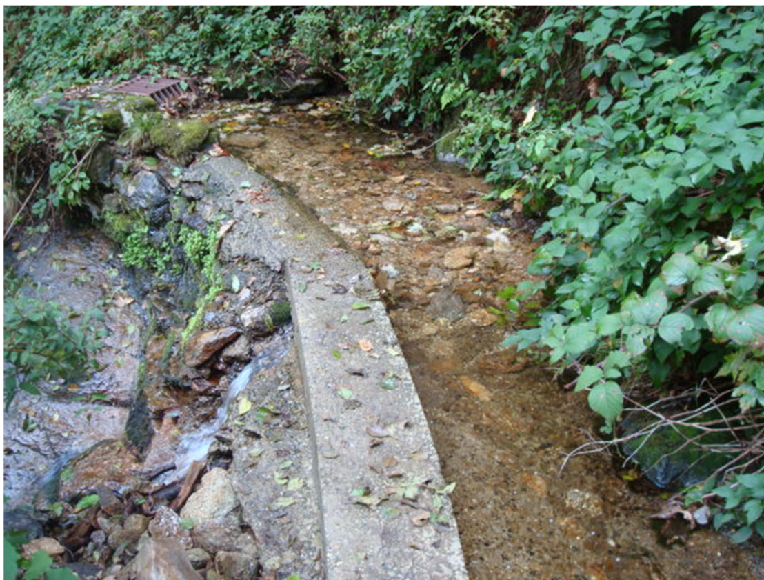
Fig. 3 - Opera di presa sul rio Moscarola
