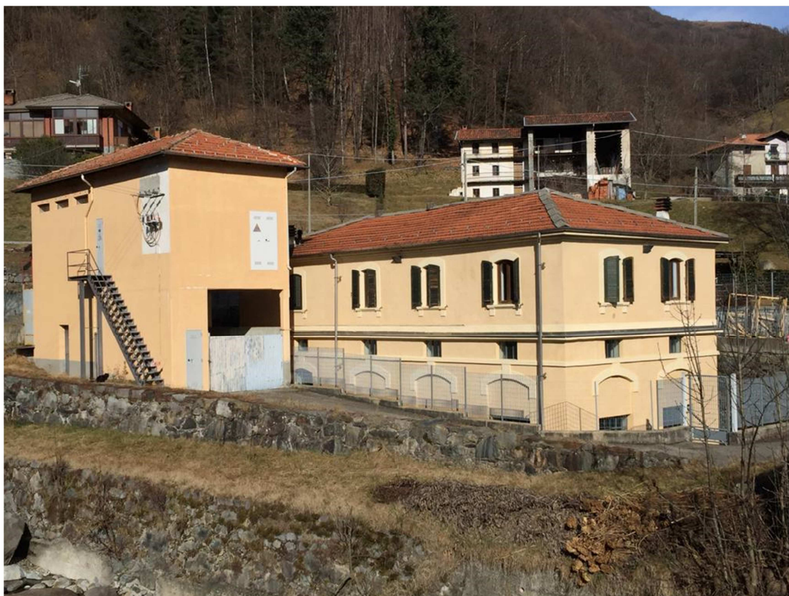
Fig. 7 – L'edificio che ospita la centrale (al piano interrato) e l'alloggio del custode al piano terra. A fianco, la cabina di consegna ENEL posta al primo piano
