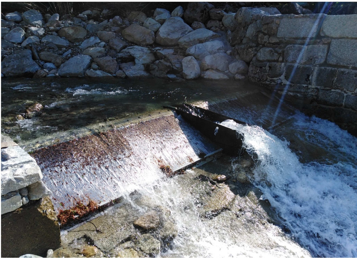
Fig. 1 – L'opera di presa sul torrente Oropa a seguito degli interventi di ripristino successivi agli eventi alluvionali dell'ottobre 2020. Al centro il dispositivo per il rilascio del DMV
