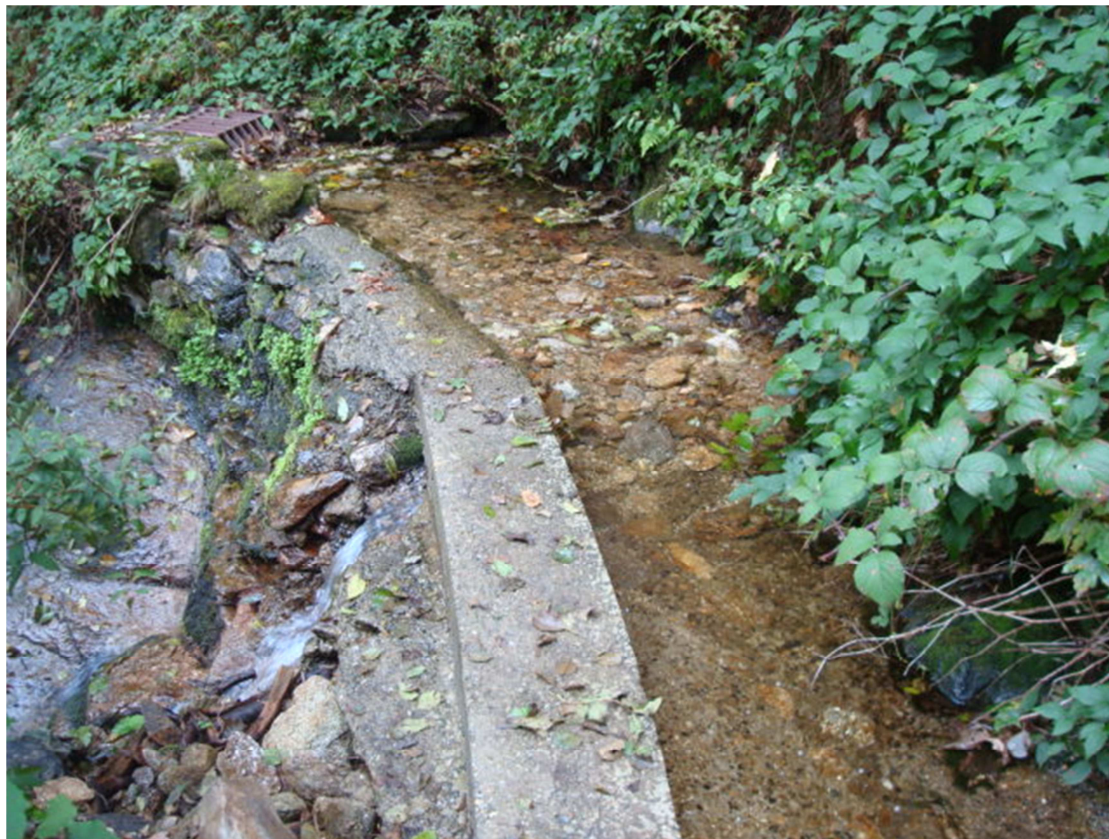
Fig. 3 - Opera di presa sul rio Moscarola
