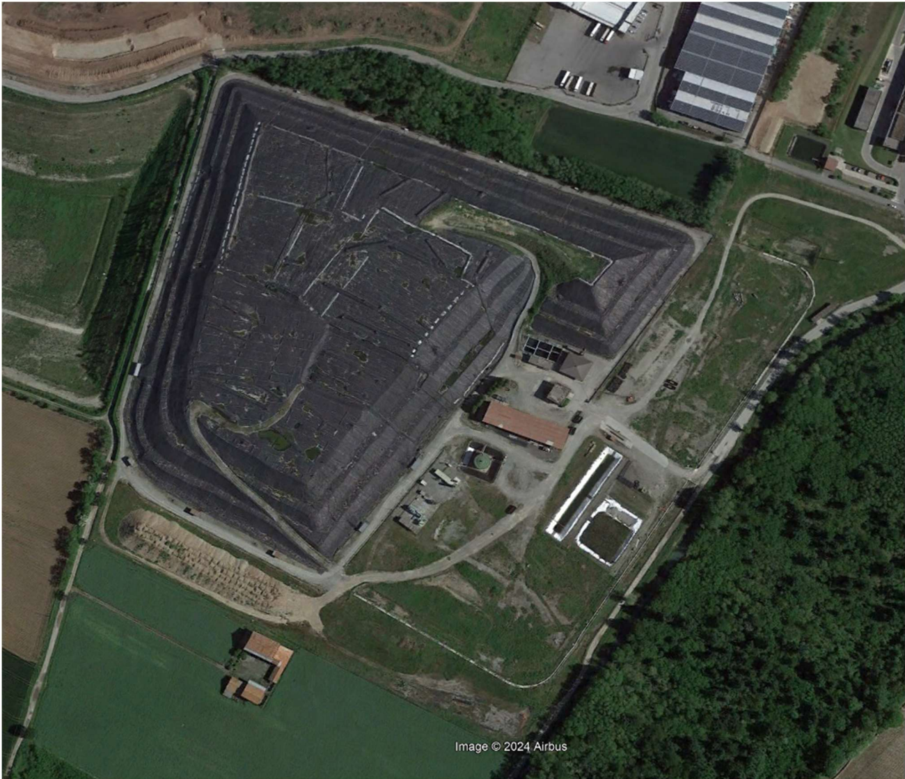
Figura 5 – Immagine satellitare area “Stazione Elettrica” nella foto sono visibili le due vasca di cui quella a destra è in disuso
