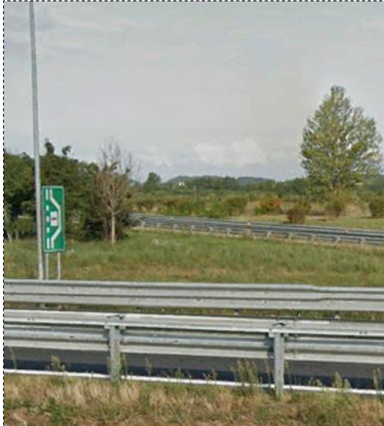
Fotoinserimento da PV18 – stato attuale - DETTAGLIO
