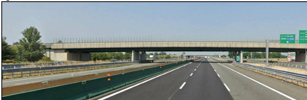
Figura 4.2.9b Autostrada A4 Torino - Milano
