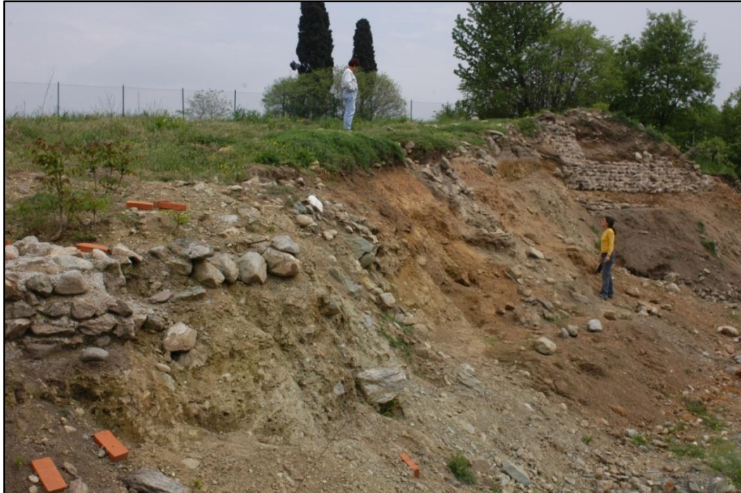
Figura 2g Particolare della sezione esposta da mettere in sicurezza ripristinando il colle (Foto L. Boni in Archivio Sabap)
