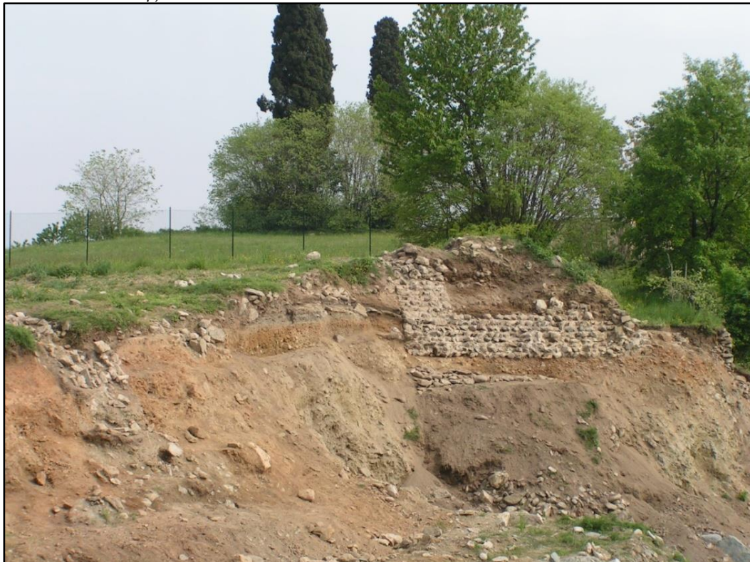
Figura 2h Particolare della cosiddetta Torre, di cui si conserva parte dell'elevato e dei livelli pavimentali (Foto L. Boni in Archivio Sabap)
