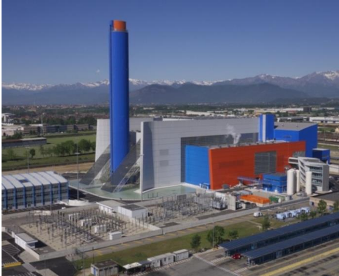
Figura 3635 - immagine dell'impianto di incenerimento di rifiuto urbani e rifiuti speciali non pericolosi d
