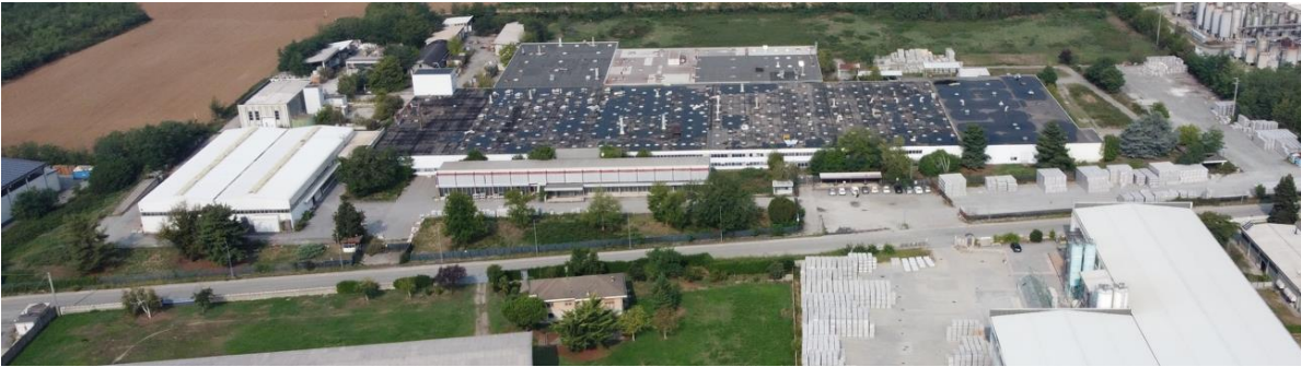
Fig.21 – Vista aerea della Ex Zincocelere da via Bertone
