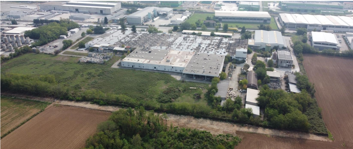
Fig. 22 – Vista aerea della Ex Zincocelere dall'Area Agricola
