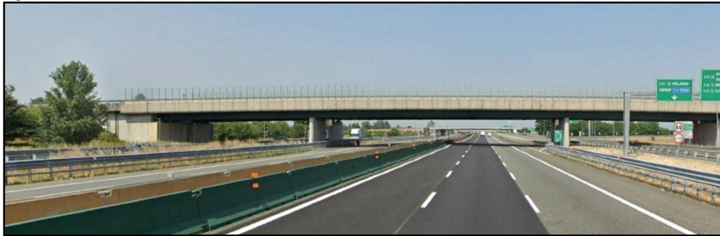
Figura 4.2.9b Autostrada A4 Torino - Milano
