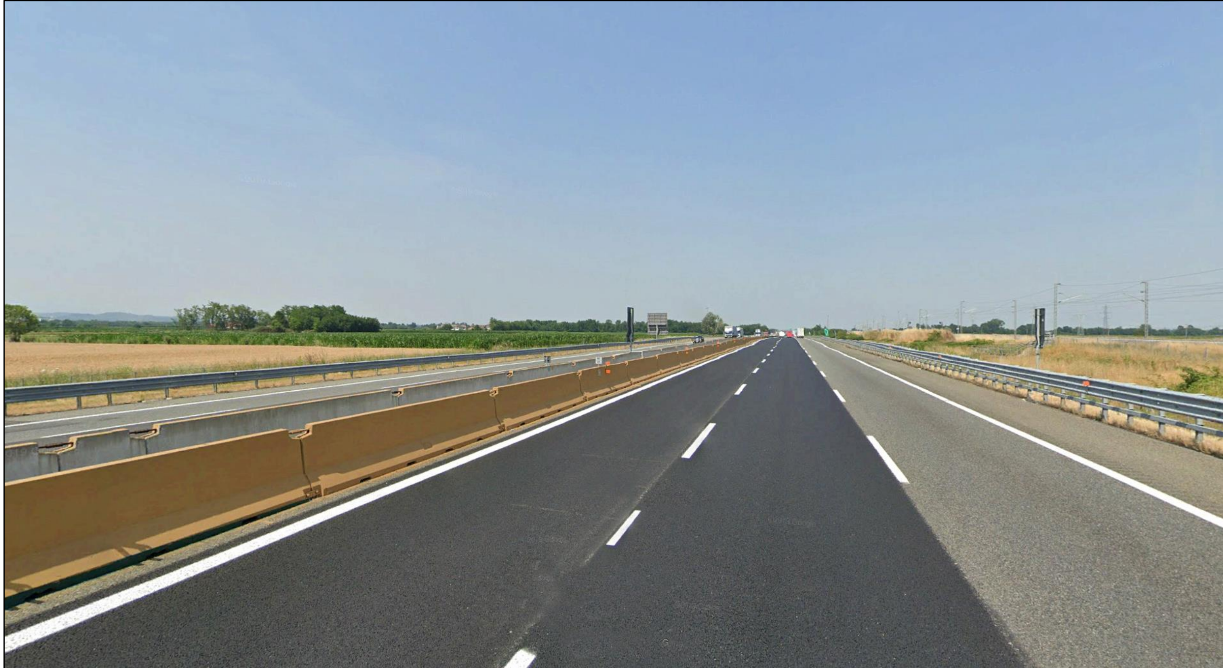
Figura 4.1.2.2r (1di2) Ripresa fotografica da PV17
