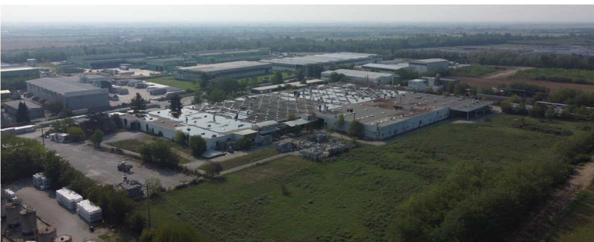
Fig.23 – Vista aerea Ex Zincocelere
