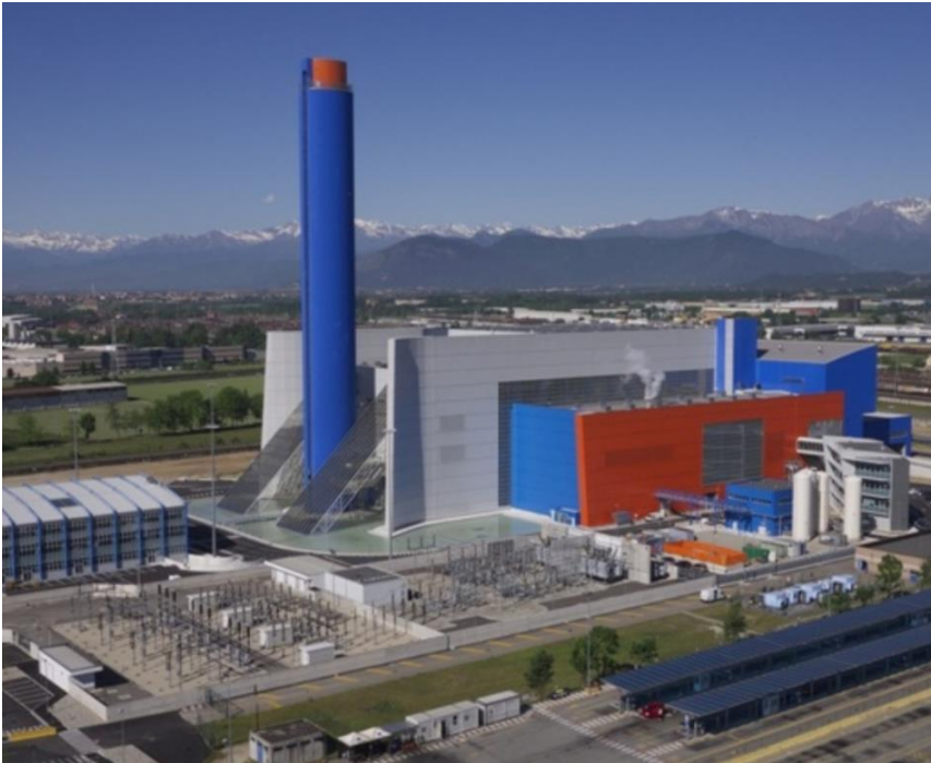
Figura 32 - immagine dell'impianto di incenerimento di rifiuto urbani e rifiuti speciali non pericolosi d
