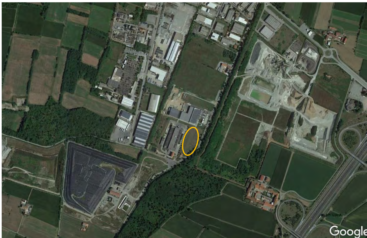
Fig. 1: Inquadramento dell'area – Stato di fatto (in giallo viene evidenziata l'area dell'installazione)
