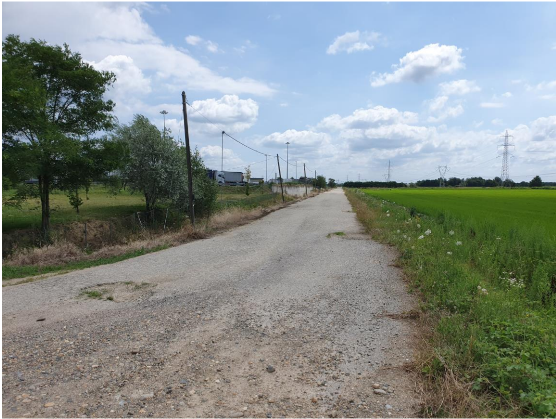
Strada accesso area Sottostazioni vista verso Est
