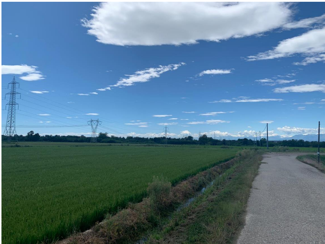
Vista area accesso SSE TERNA
