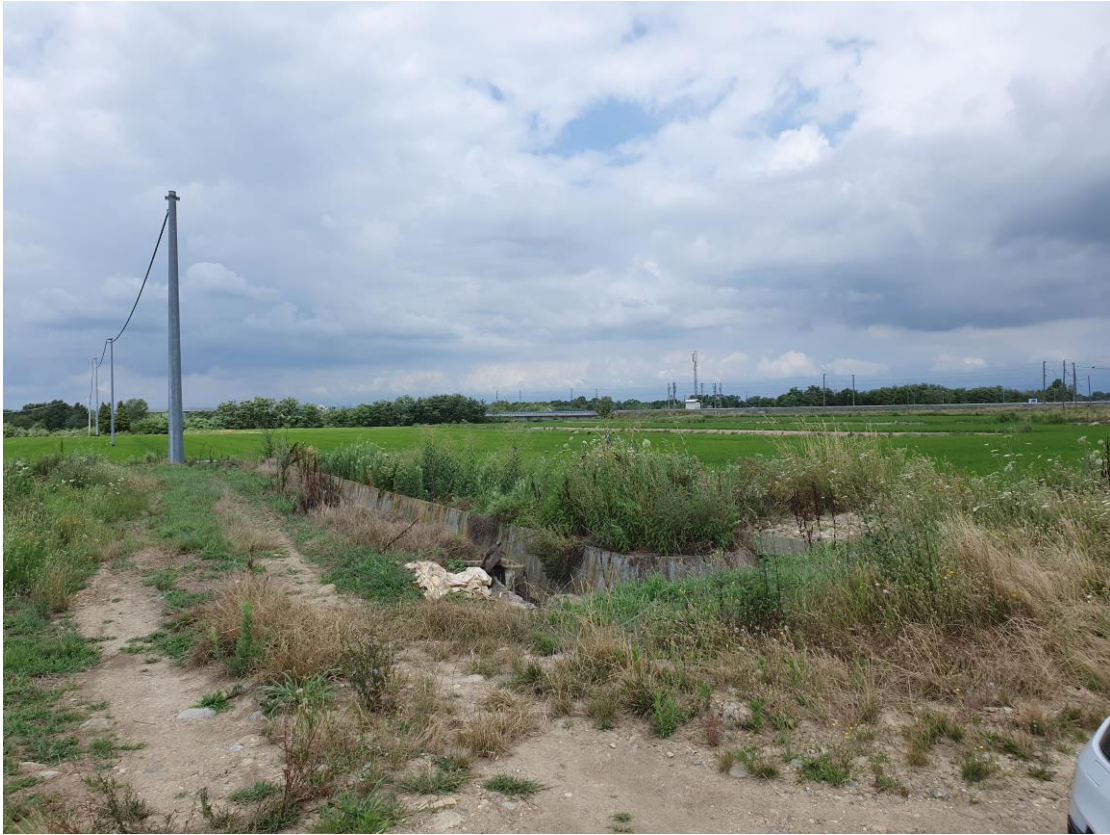
Dettaglio area accesso SSE TERNA
