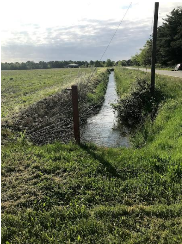
Figura 9 - FOTO FOSSO LUNGO LA STRADA PROVINCIALE
