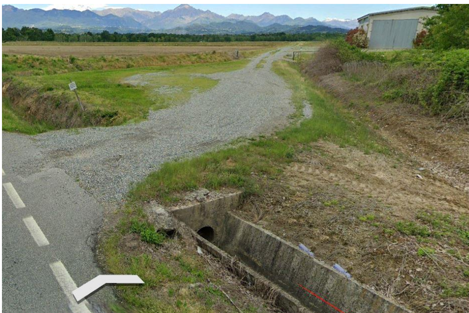
FIGURA 4 - VISTA DA STRADA PROVINCIALE SP317
