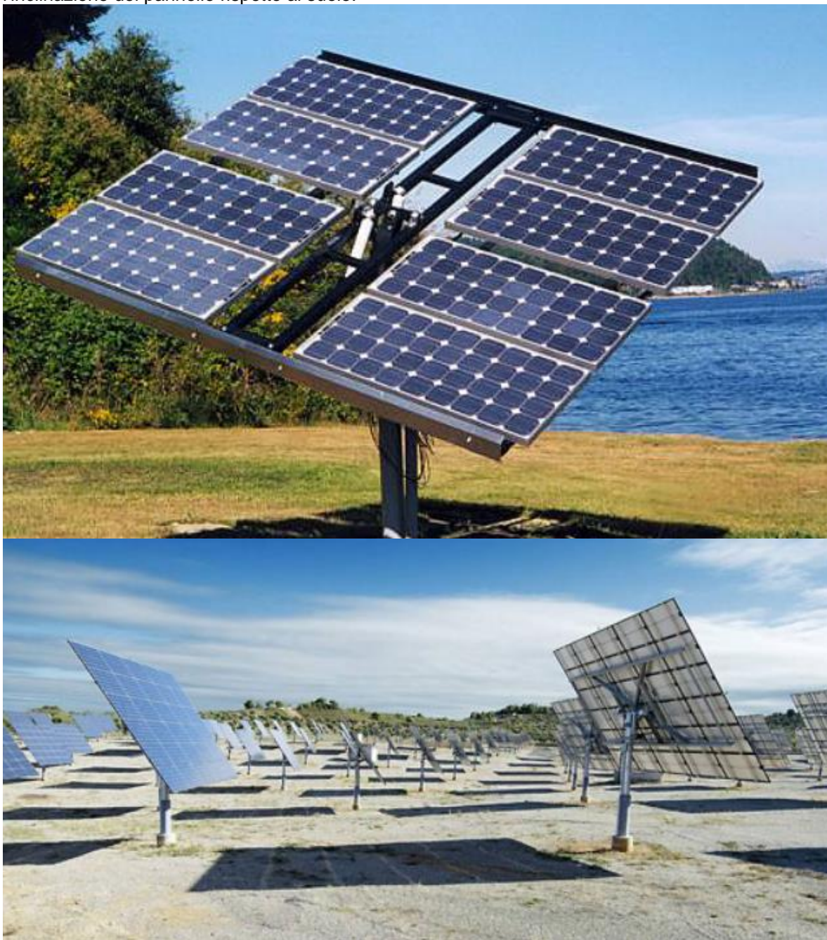
Figura 5 INSEGUITORI DI AZIMUTH
