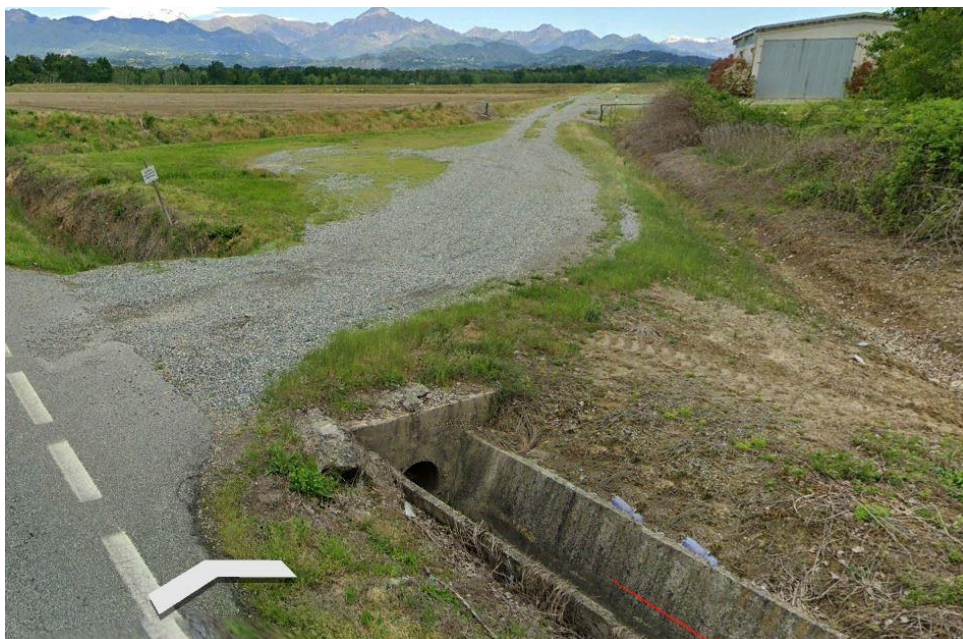
FIGURA 8 - VISTA DA STRADA PROVINCIALE SP317
