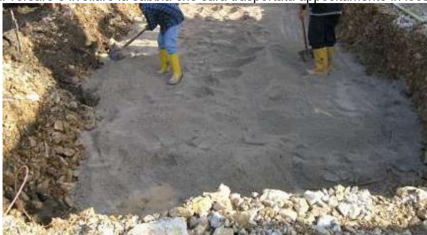
FIGURA 5 - SBANCAMENTO PIANO POSA CABINE
