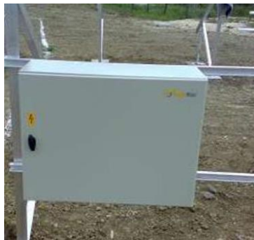
FIGURA 9 - QUADRI IN PARALLELO
