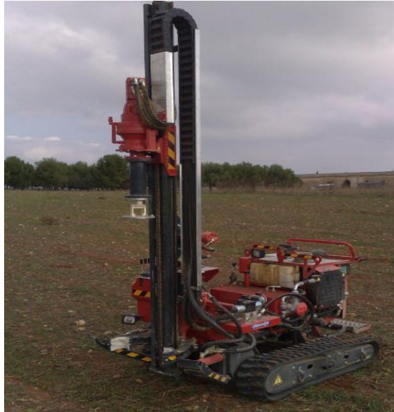
FIGURA 7 - MACCHINA BATTIPALO PER INFIESSIONE PALI
