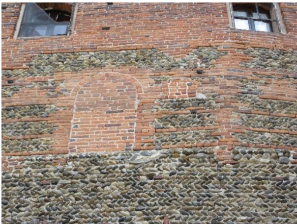
Castello di Rovasenda, tamponature prospetto sud ovest
