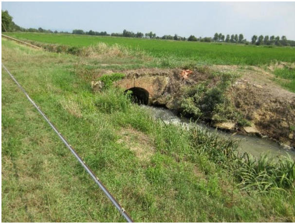
Attraversamento canale irriguo, da sud ovest
