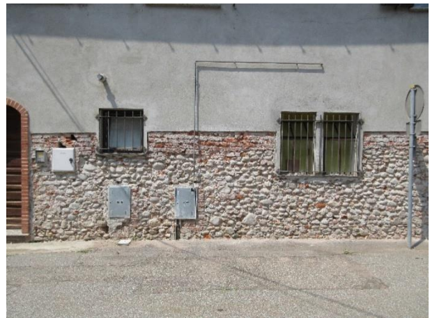
Via Garibaldi 5, dettaglio paramento murario
