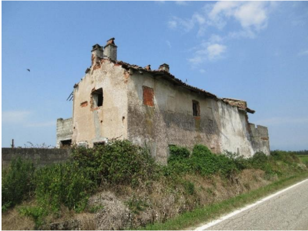
Cascinale lato strada, da sud est
