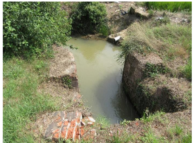
Attraversamento canale, dettaglio di ingresso, da ovest
