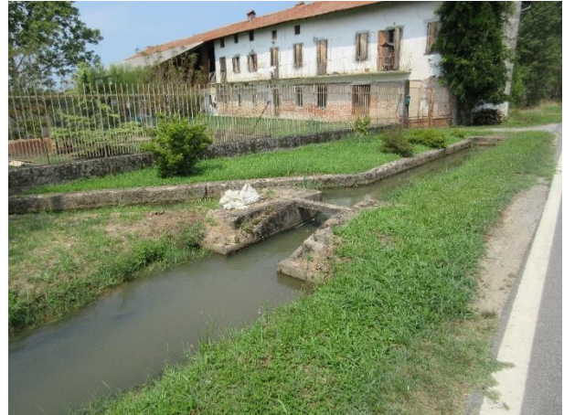
Attraversamento canale, da sud est
