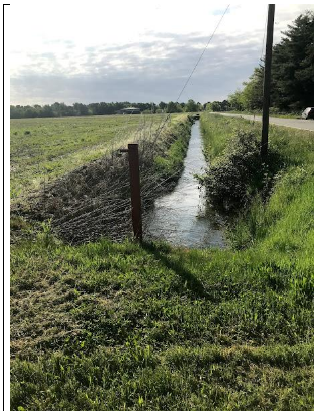
FIGURA 1 - FOTO FOSSO LUNGO LA STRADA PROVINCIALE
