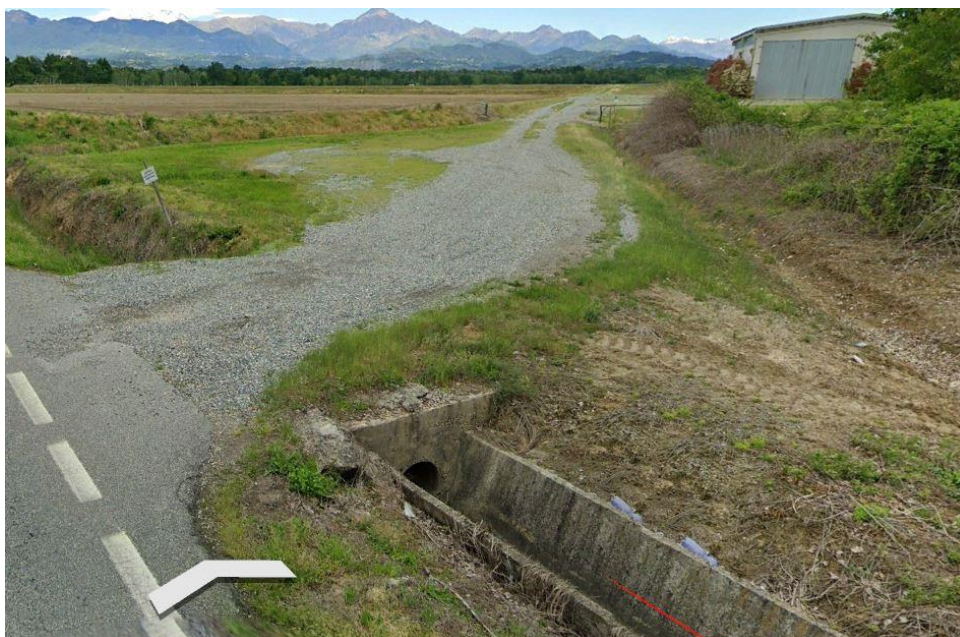
FIGURA 2 - VISTA DA STRADA PROVINCIALE SP317
