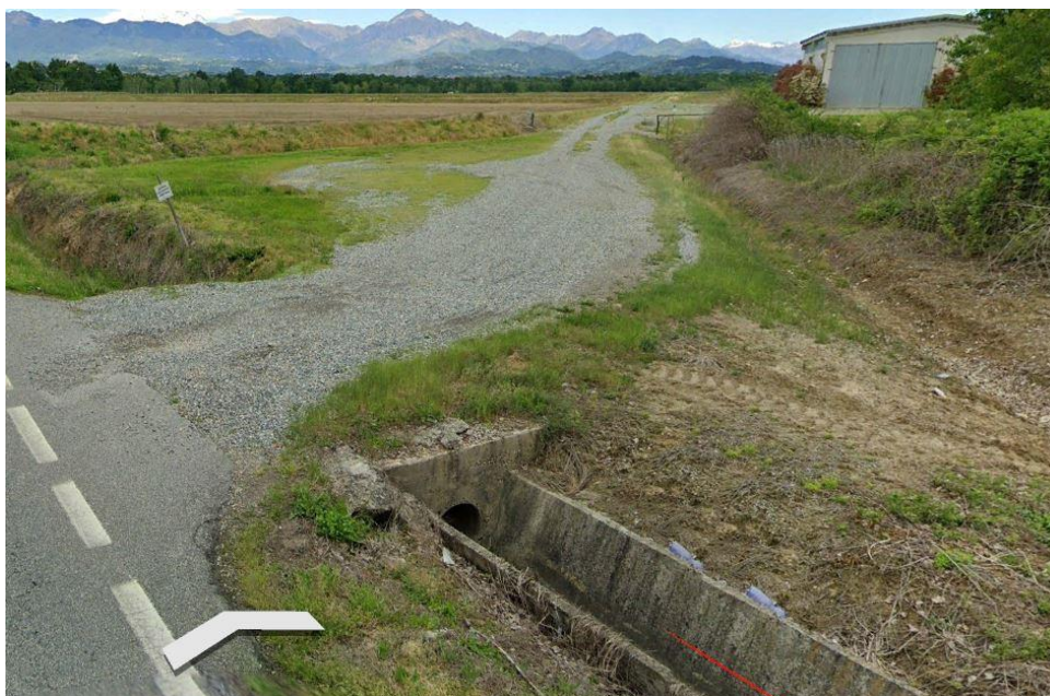
FIGURA 6 - VISTA DA STRADA PROVINCIALE SP317
