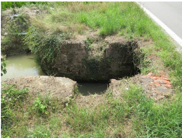
Attraversamento canale, dettaglio di ingresso, da nord
