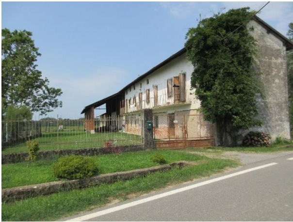
Cascinale lato strada, da sud est
