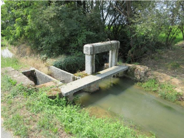
Attraversamento canale, dettaglio di uscita, da nord est
