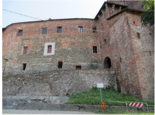
Castello di Rovasenda, prospetto sud ovest
