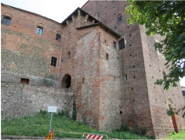
Castello di Rovasenda, prospetto sud ovest
