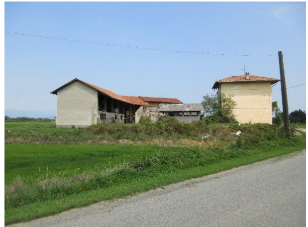
Cascinale lato strada Galoppa, da sud
