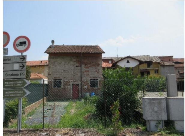
Incrocio SP64 – via Cavour, da ovest
