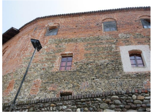
Castello di Rovasenda, dettaglio prospetto sud ovest
