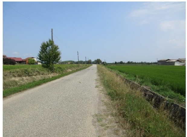
Strada Galoppa, da sud ovest
