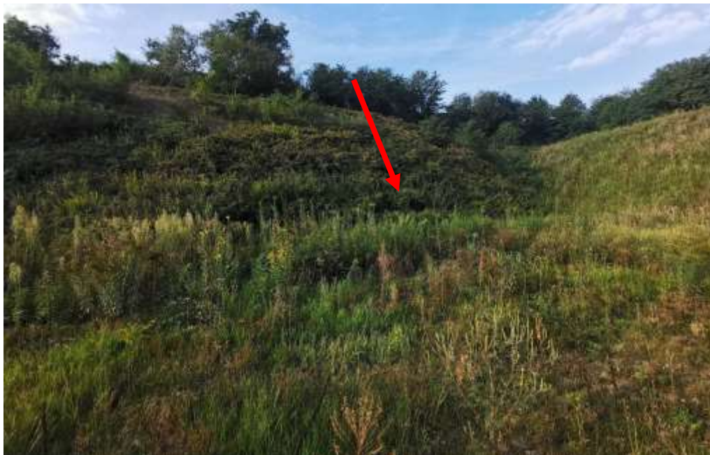
Fig. Lato Sud _Canalette naturali realizzate in contropendenza poste in mezzeria della scarpata e alla base dei versanti.
