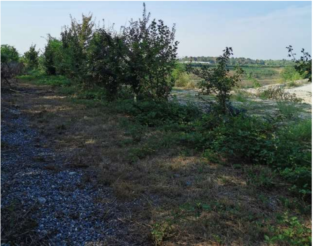
Fig. – Lato Est_Fosso di gronda in contropendenza verso l'esterno
