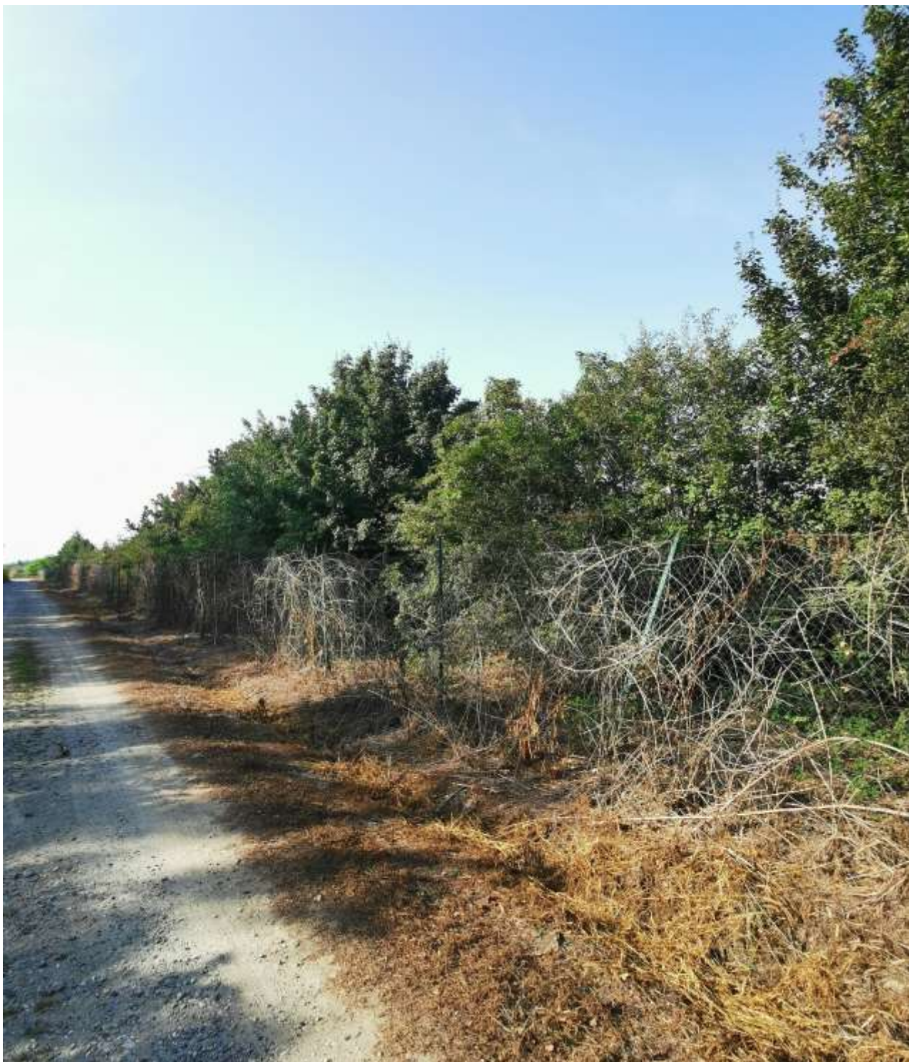
Fig.- Lato EST_Canalette di raccolta acqua meteoriche a partire dalla strada dei Ronchi
