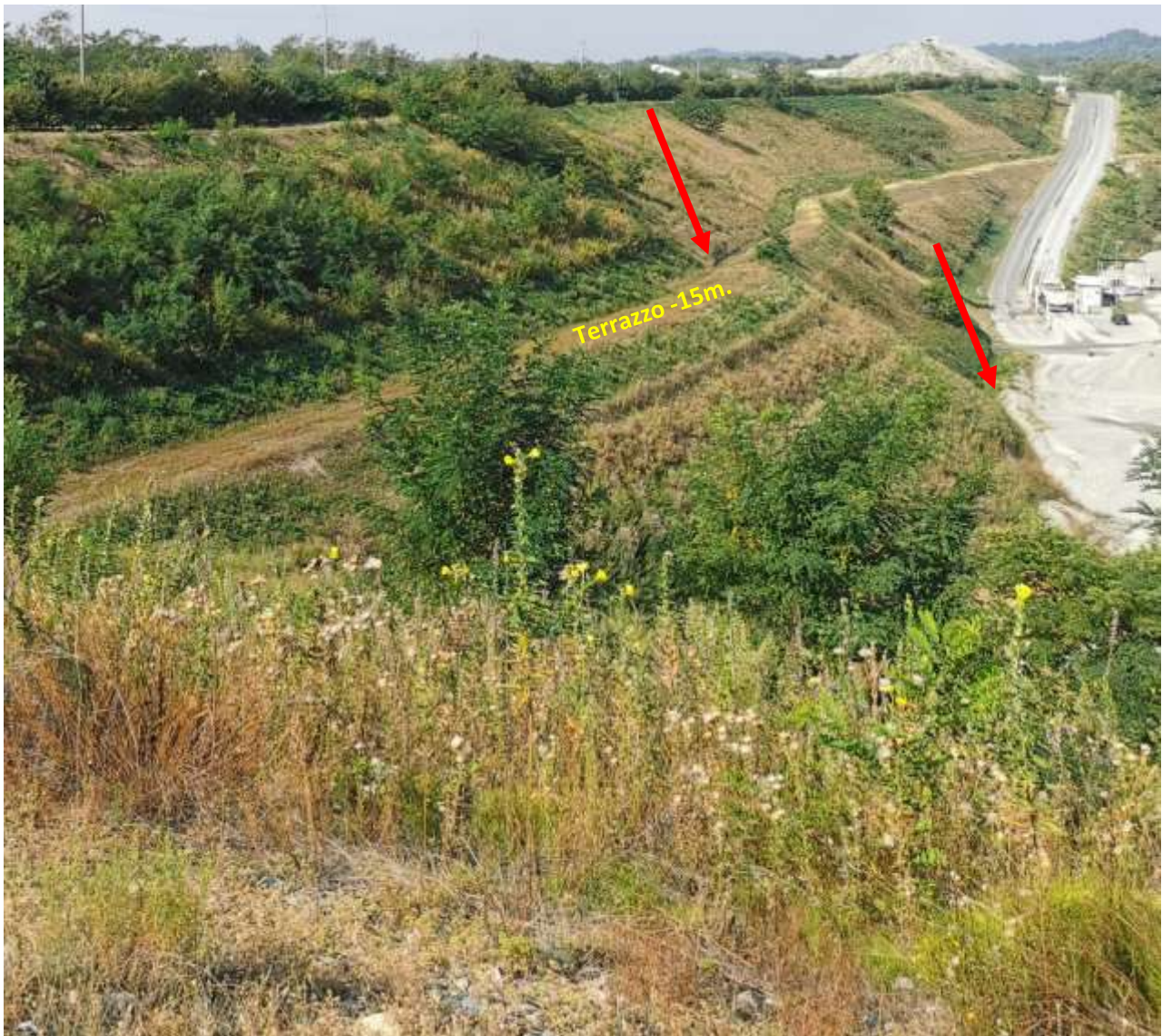
Fig. Lato Sud _Canalette naturali realizzate in contropendenza poste in mezzeria della scarpata e alla base dei versanti.
