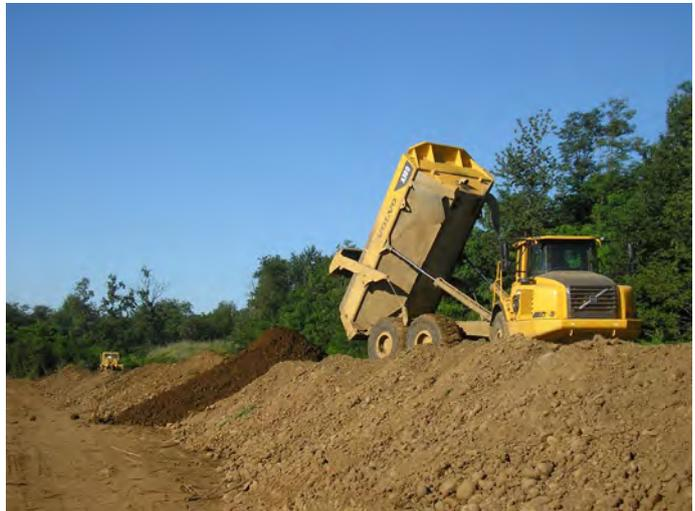
Tale terreno verrà temporaneamente accumulato, prevalentemente all'interno delle fasce di rispetto dell'area di cava in cumuli trapezoidali di dimensione variabile in funzione della larghezza della fascia di rispetto in cui verranno collocati nelle rimanenti zone di cava.
