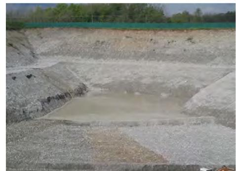
Le operazioni di svuotamento di uno dei due bacini, operazioni che verranno eseguite unicamente quando i lavori di recupero ambientale richiederanno delle volumetrie di limo, saranno eseguite mediante la creazione di una rampa di accesso al fondo vasca, dalla quale si accederà con escavatore cingolato per le operazioni di carico sui dumper ed il successivo asporto con gli stessi, del limo. Nella foto a lato si può vedere una delle attuali vasche provvisorie in fase di svuotamento.
