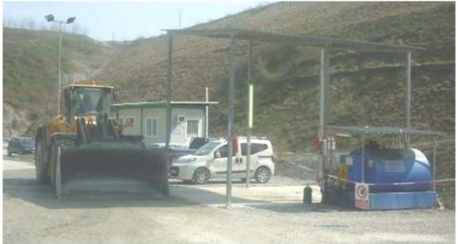
rifornimento dei mezzi di cava con serbatoio mobile, il carburante possa riversarsi nel terreno, inquinandolo, e successivamente raggiungere la falda sottostante, si è realizzato un'area per i rifornimenti ed installato un serbatoio di cantiere
