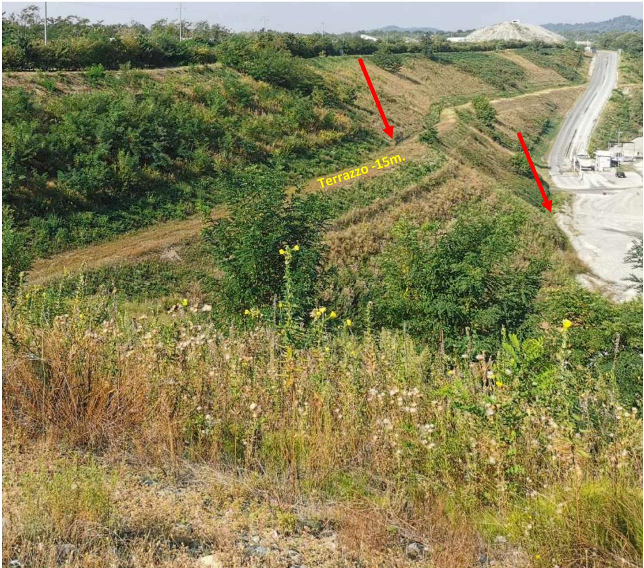
Fig. Lato Sud \_Canalette naturali realizzate in contropendenza poste in mezzeria della scarpata e alla base dei versanti.
