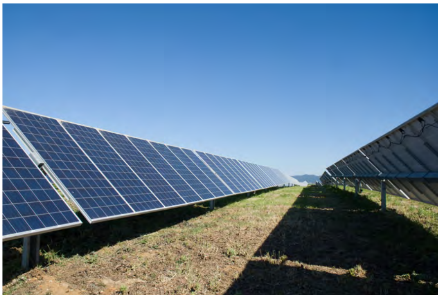
Tipiche strutture ad inseguimento monoassiale
