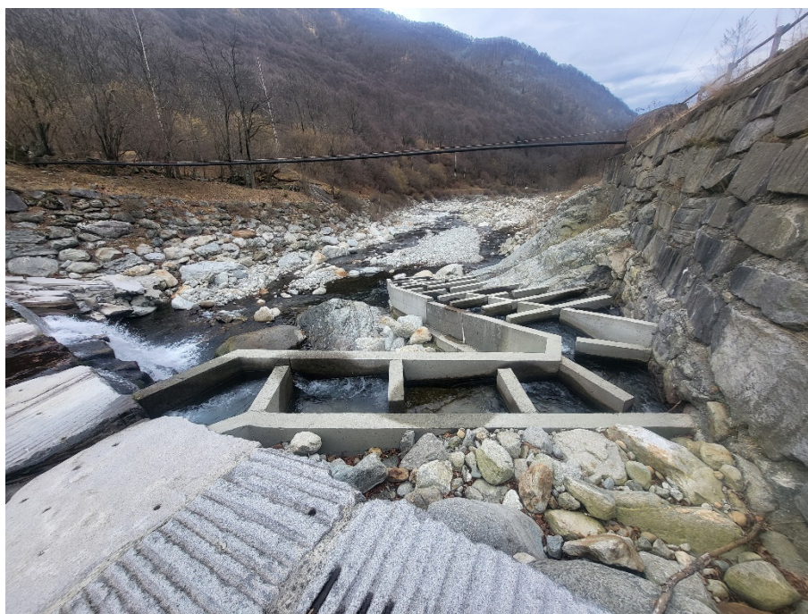
Figura 2.2: Vista Scala di risalita da monte verso valle
