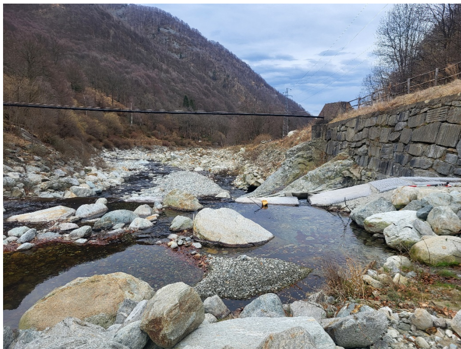
Figura 2.1: Vista luce di alimentazione su traversa
