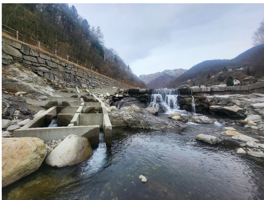
Figura 2.3. Vista Scala di risalita da valle verso monte
