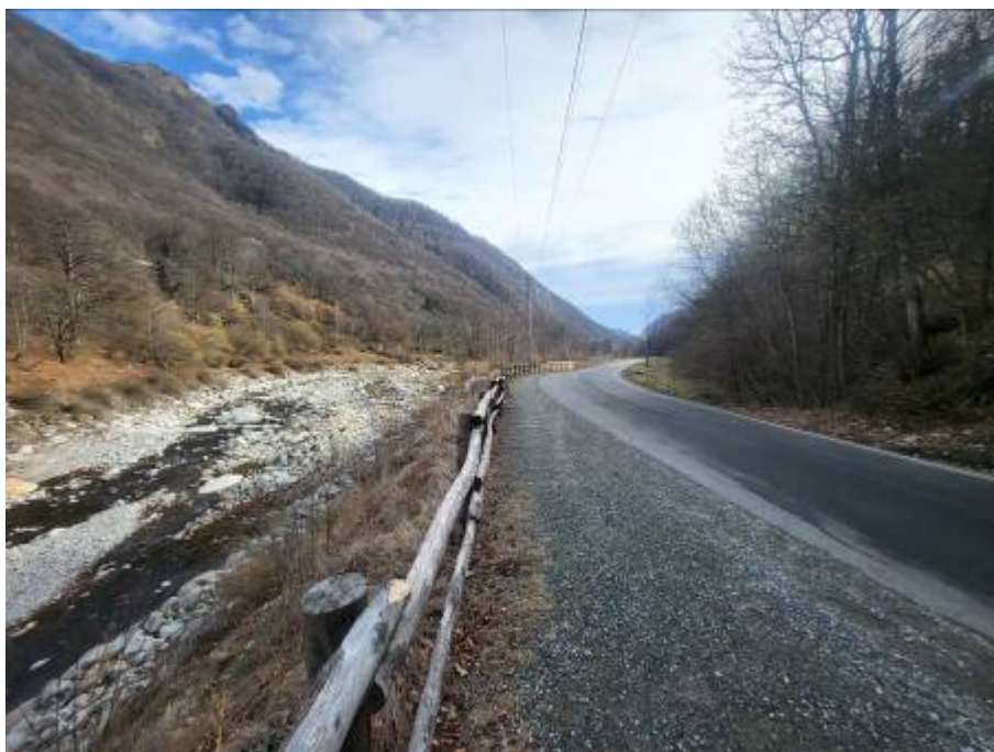
Figura foto 21: tracciato della condotta a fianco della strada (fotografia del 01/02/2024)
