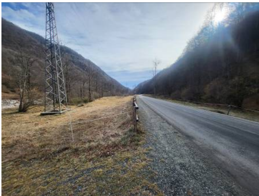
Figura foto 23: tracciato della condotta a fianco della strada e della pista pedonale (fotografia del 01/02/2024)
