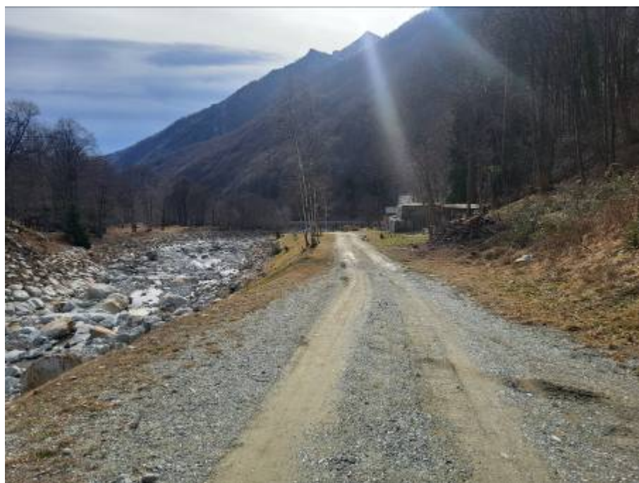
Figura foto 14: pista di accesso alla presa sopra tracciato condotta forzata (fotografia del 01/02/2024)
