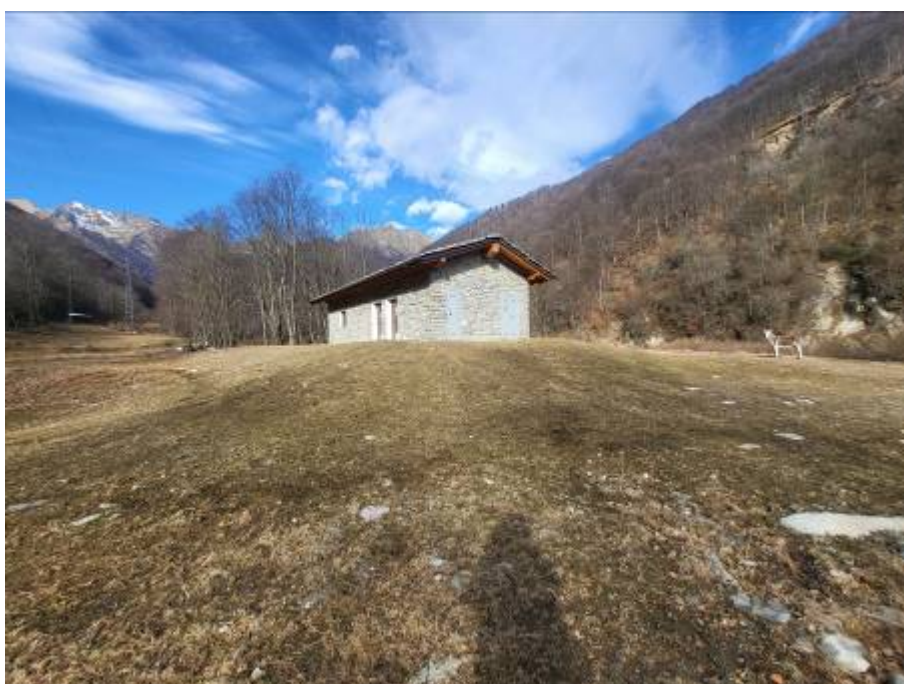
Figura foto 34: centrale di produzione vista da palo di sostegno linea area MT
