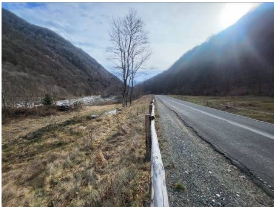
Figura foto 25: tracciato della condotta a fianco della strada e della pista pedonale (fotografia del 01/02/2024)
