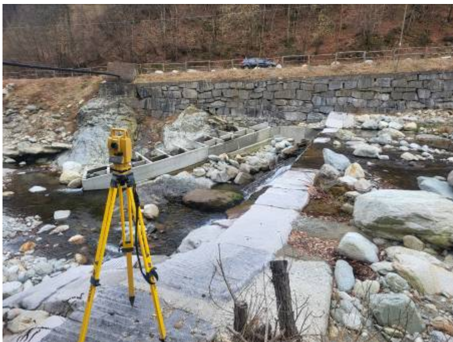
Figura foto 45: scala di risalita ittiofauna (fotografia del 01/02/2024)
