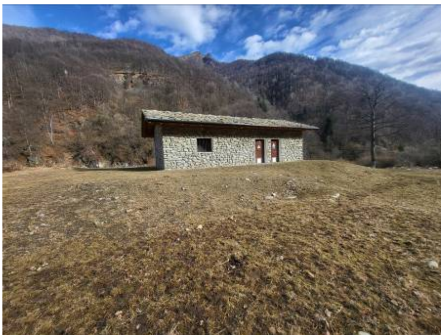
Figura foto 32: centrale idroelettrica (fotografia del 01/02/2024)
