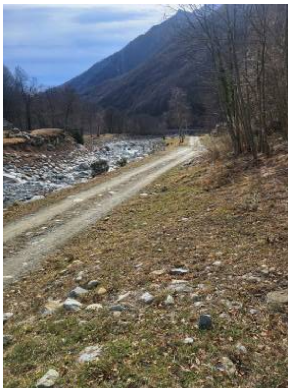
Figura foto 13: vista da vasca di carico a tracciato condotta forzata (fotografia del 01/02/2024)
