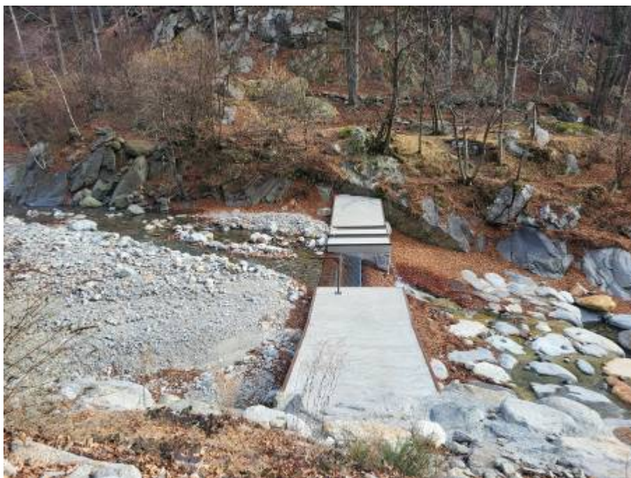
Figura foto 5: traversa di captazione (fotografia del 01/02/2024)
