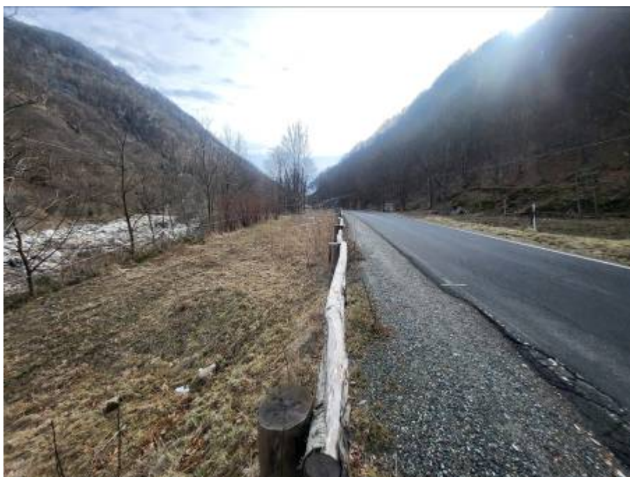
Figura foto 26: tracciato della condotta a fianco della strada e della pista pedonale (fotografia del 01/02/2024)
