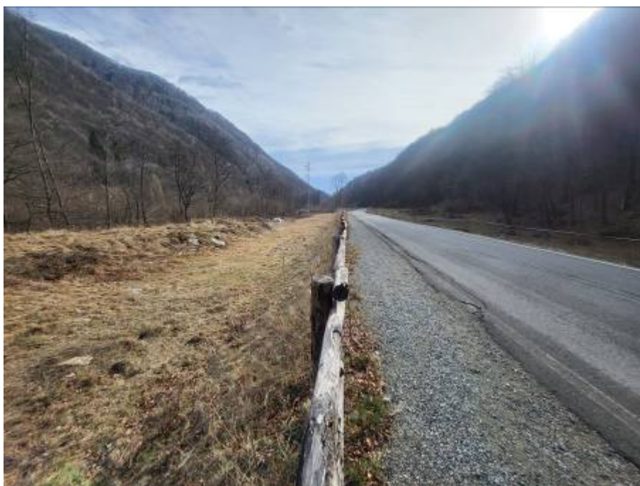
Figura foto 24: tracciato della condotta a fianco della strada e della pista pedonale (fotografia del 01/02/2024)
