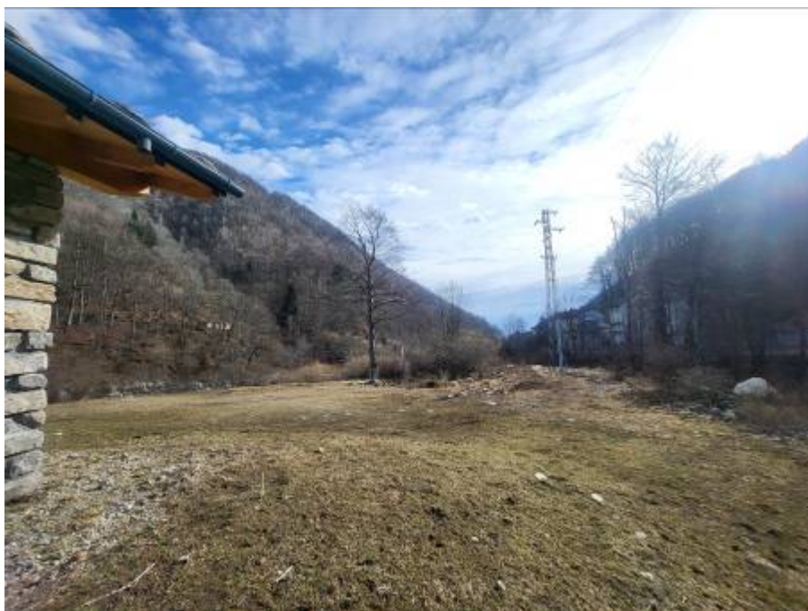
Figura foto 33: palo di sostegno della linea aerea MT presso il quale avviene la connessione tramite posa di cavo interrato (fotografia del 01/02/2024)
