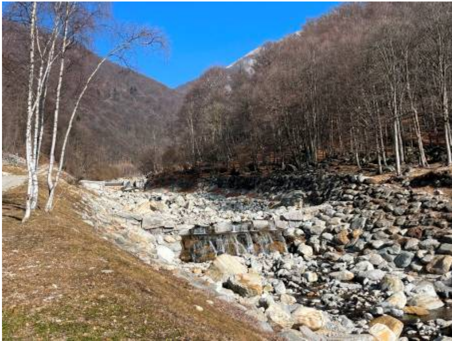
Figura foto 11: vista panoramica del T. Chiobbia con traversa di derivazione sullo sfondo e briglia di regimazione sottoposta a interventi di consolidamento durante l'esecuzione dei lavori in primo piano; fra le due opere si intravede con difficoltà la briglia ammalorata a seguito dell'evento alluvionale del 2-3 ottobre 2020 dove era prevista la captazione come da progetto (fotografia del 21/02/2023)
