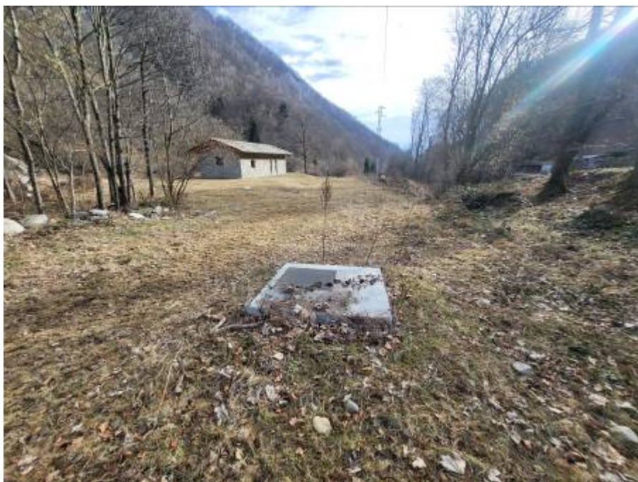
Figura foto 31: tracciato della condotta in avvicinamento alla centrale (fotografia del 01/02/2024)
