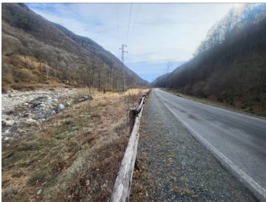
Figura foto 22: tracciato della condotta a fianco della strada e della pista pedonale (fotografia del 01/02/2024)
