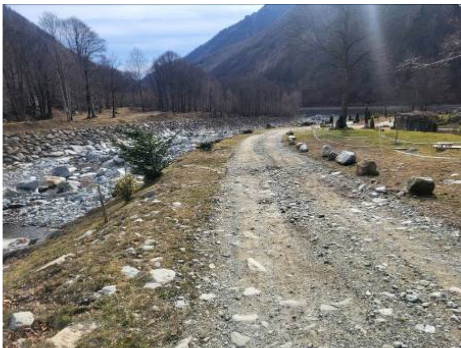
Figura foto 15: pista di accesso alla presa sopra tracciato condotta forzata (fotografia del 01/02/2024)
