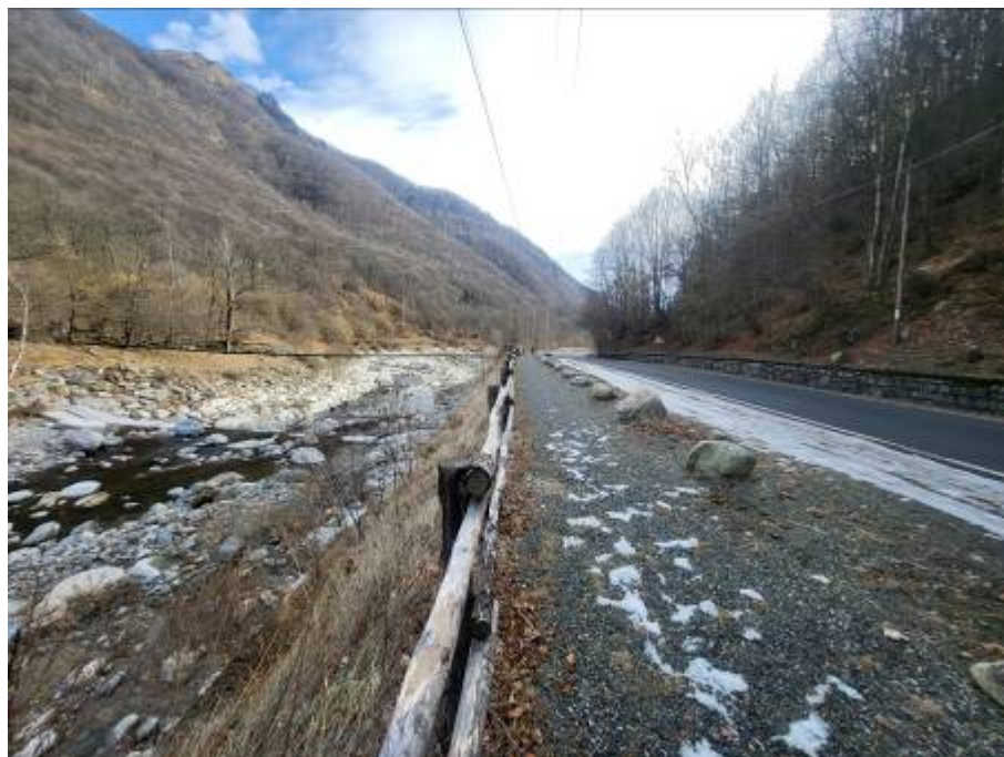
Figura foto 20: tracciato della condotta a fianco della strada (fotografia del 01/02/2024)
