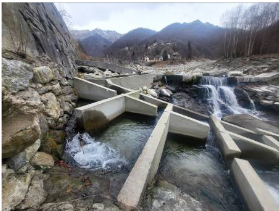
Figura foto 49: dettaglio scala di risalita ittiofauna (fotografia del 01/02/2024)
