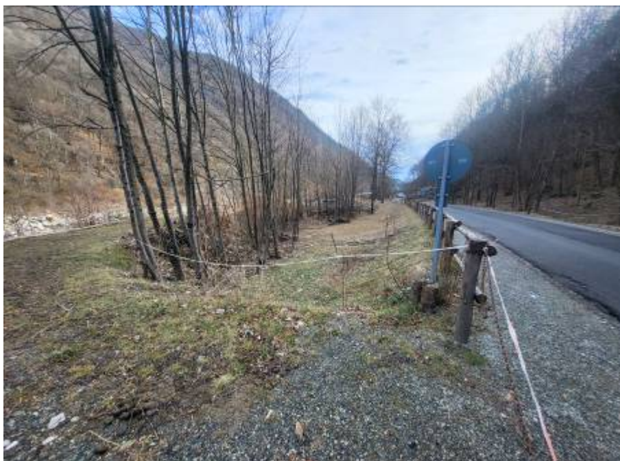
Figura foto 28: tracciato della condotta a fianco della strada e della pista pedonale e ingresso pista di accesso alla centrale (fotografia del 01/02/2024)
