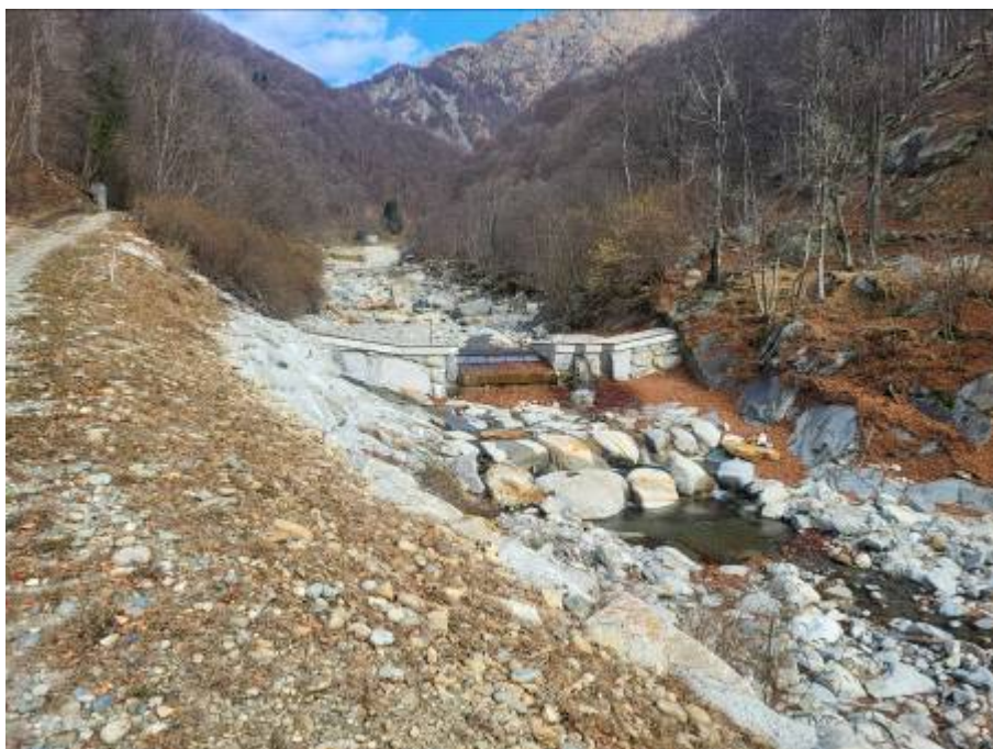
Figura foto 3: traversa di captazione (fotografia del 21/02/2023)
