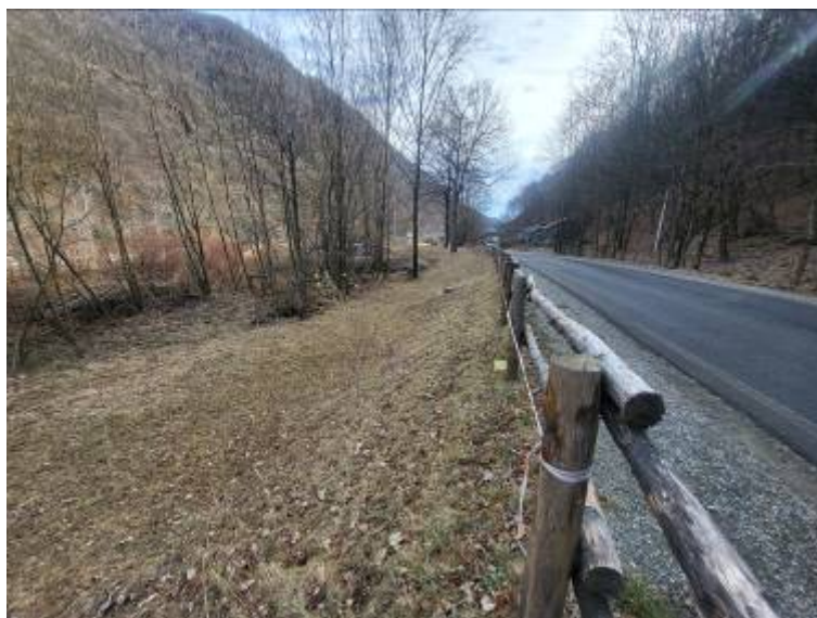
Figura foto 29: tracciato della condotta a fianco della strada e della pista pedonale e ingresso pista di accesso alla centrale (fotografia del 01/02/2024)
