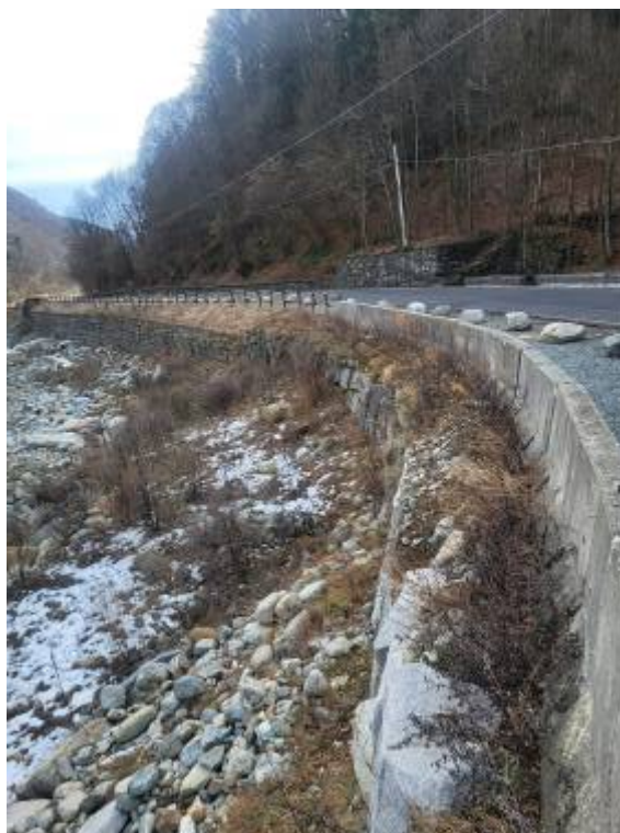
Figura foto 18: tracciato della condotta a valle del Ponte Pinchiolo (fotografia del 01/02/2024)
