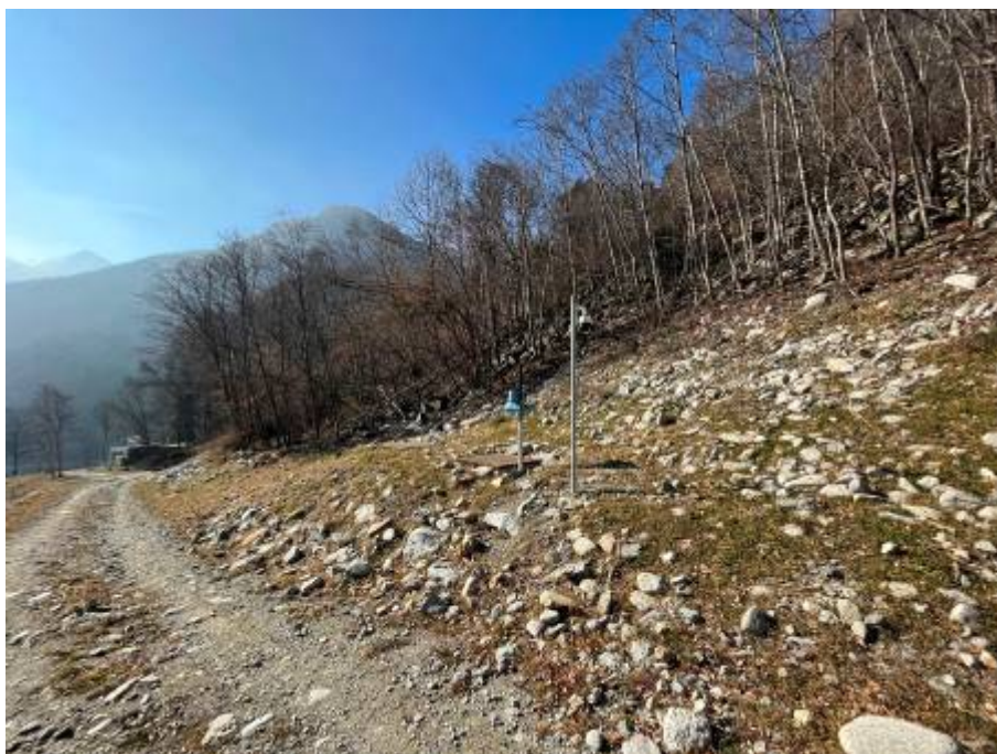
Figura foto 10: vasca dissabbiatrice / carico completamente interrata ad esclusione delle botole di accesso, stelo della paratoia e palo videocamera (fotografia del 21/02/2023)
