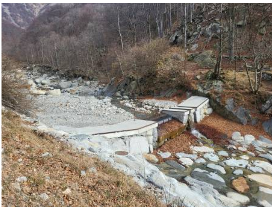
Figura foto 4: traversa di captazione (fotografia del 01/02/2024)
