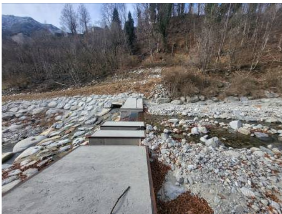
Figura foto 6: traversa di captazione (fotografia del 01/02/2024)
