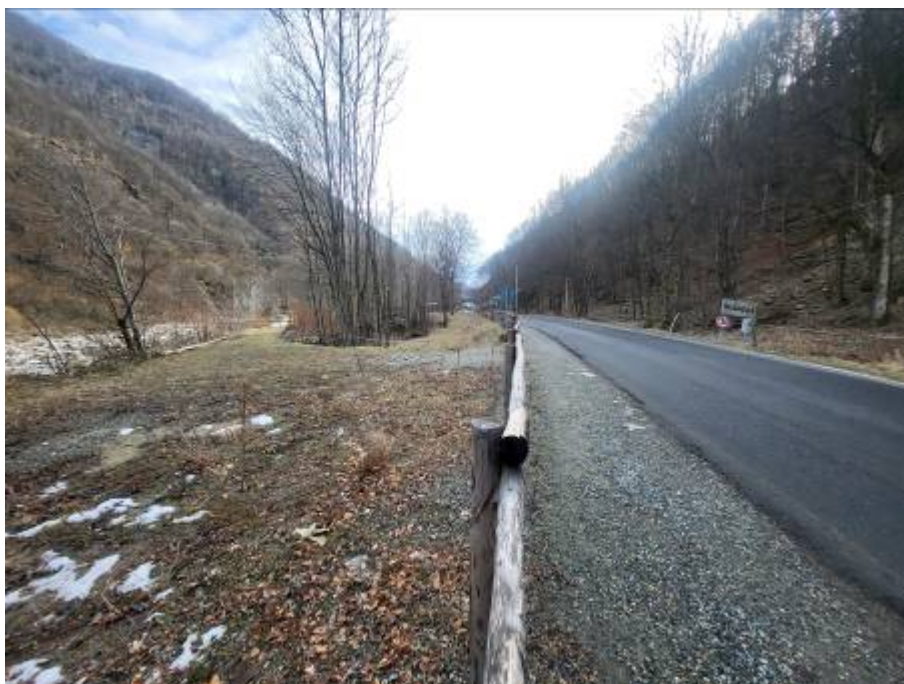
Figura foto 27: tracciato della condotta a fianco della strada e della pista pedonale e ingresso pista di accesso alla centrale (fotografia del 01/02/2024)
