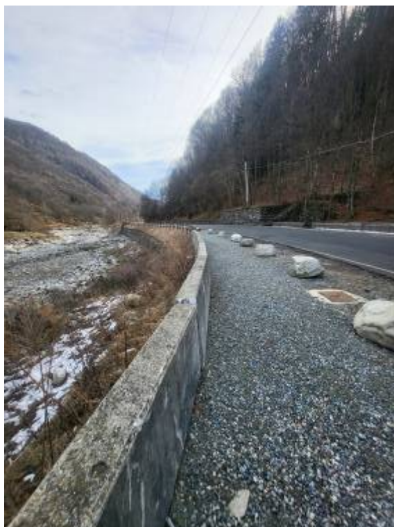
Figura foto 19: tracciato della condotta a fianco della strada (fotografia del 01/02/2024)
