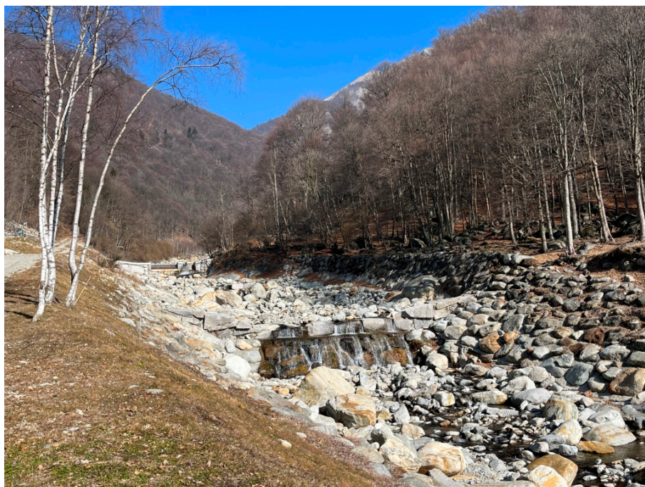
Fotografia 5: vista panoramica del T. Chiobbia con traversa di derivazione sullo sfondo e briglia di regimazione sottoposta a interventi di consolidamento durante l'esecuzione dei lavori in primo piano; fra le due opere si intravede con difficoltà la briglia ammalorata a seguito dell'evento alluvionale del 2-3 ottobre 2020 dove era prevista la captazione come da progetto (fotografia del 21/02/2023)
