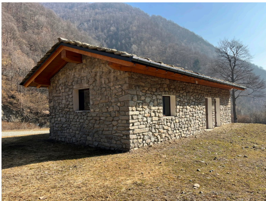
Fotografia 13: centrale idroelettrica (fotografia del 21/02/2023)
