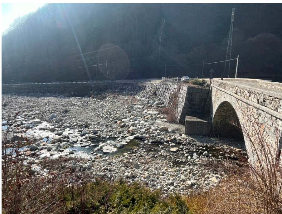
Fotografia 8: attraversamento del T. Cervo della condotta in subalveo a valle del Ponte Pinchiolo (fotografia del 21/02/2023)
