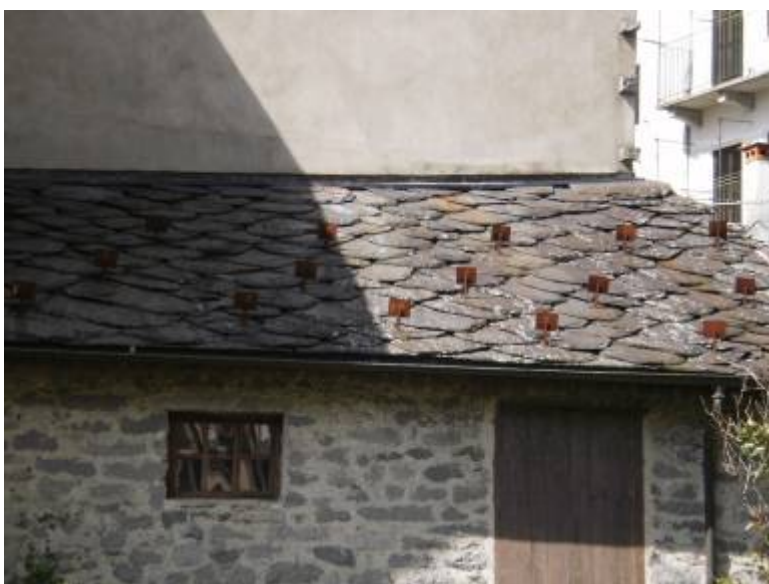
Figura 3.5: dettaglio di un edificio del contesto rurale: i muri in pietra (sienite) e la copertura in lose e il legno per gli altri elementi strutturali.
