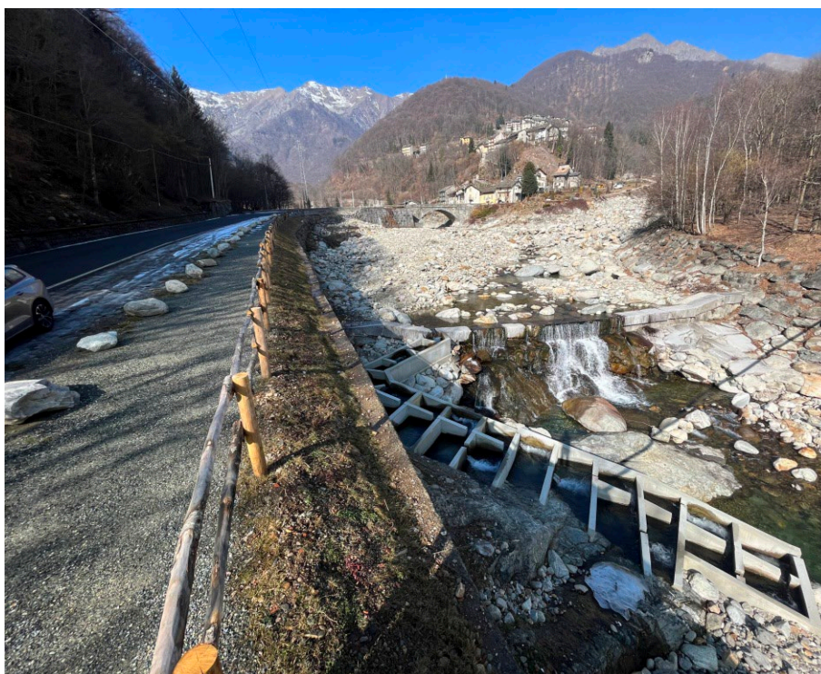
Fotografia 9: scala di risalita dell'ittiofauna presso la briglia a valle della confluenza del T. Chiobbia in T. Cervo (fotografia del 21/02/2023)
