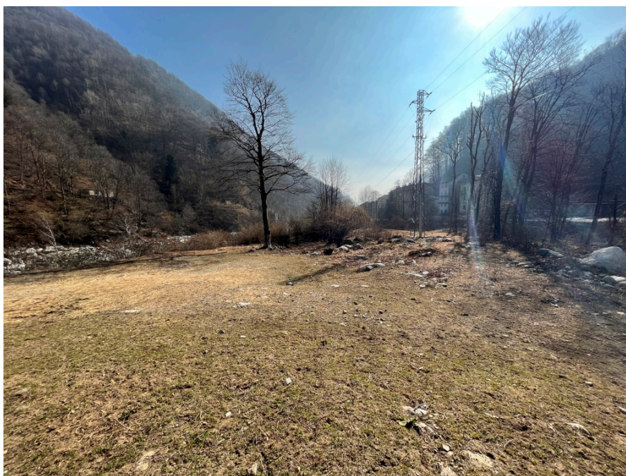
Fotografia 14: palo di sostegno della linea aerea MT presso il quale avviene la connessione tramite posa di cavo interrato (fotografia del 21/02/2023)
