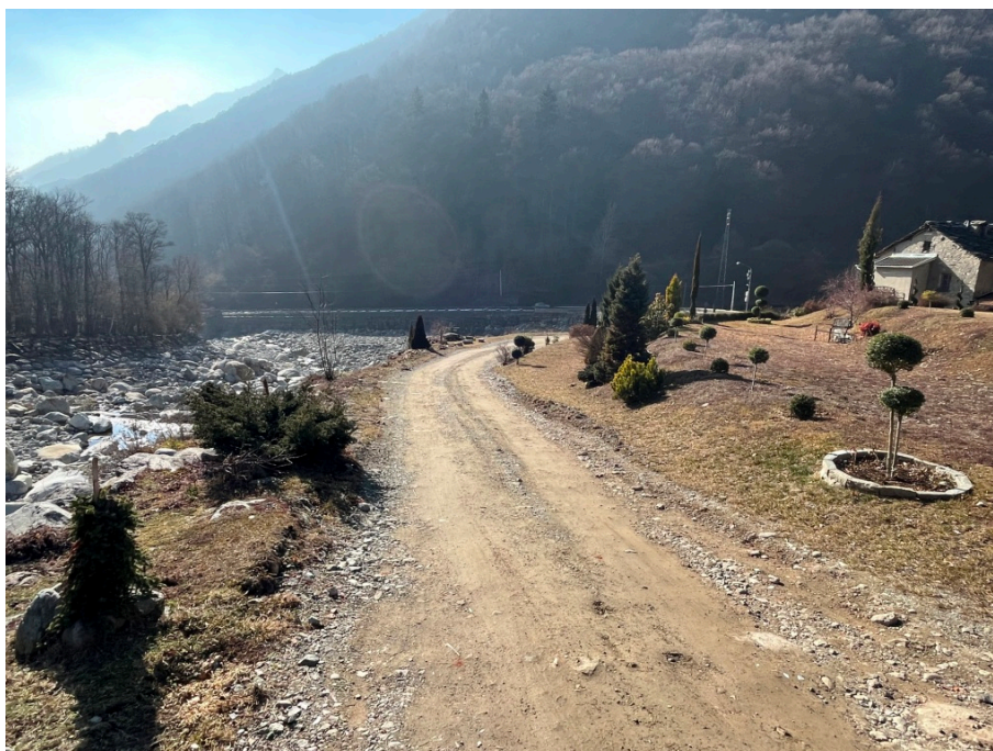
Fotografia 7: pista sterrata al di sotto della quale è posata la condotta forzata (fotografia del 21/02/2023)
