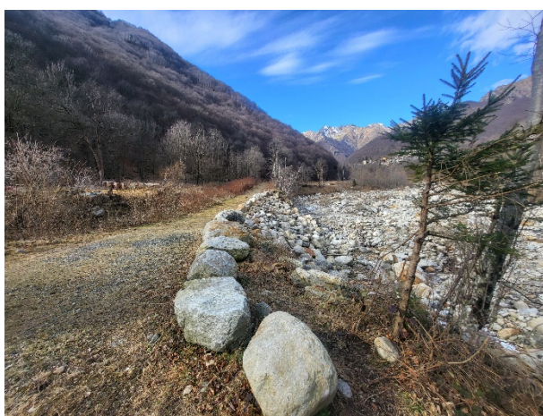
Figura 15.1: Area di realizzazione della mantellata lungo la pista di accesso dalla centrale vista 1.
