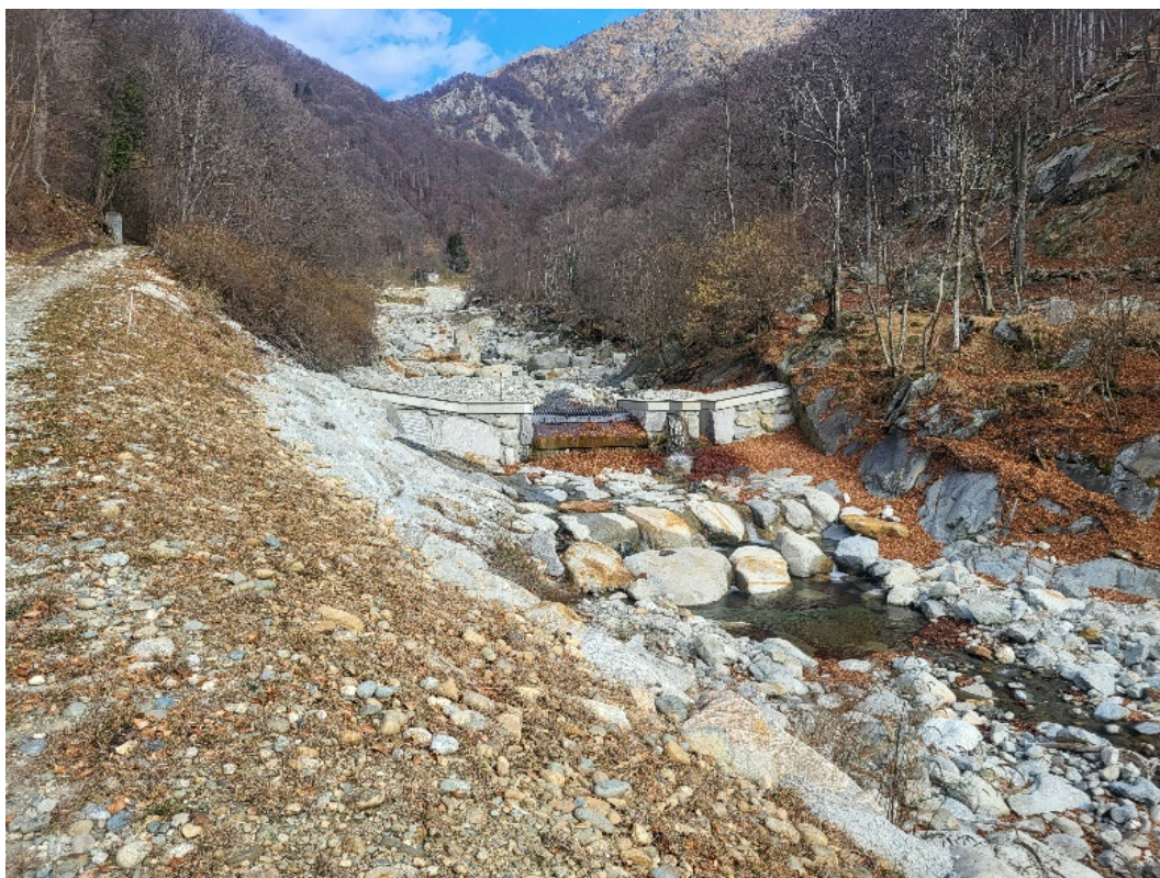
Figura 12.1: Ripresa da valle della traversa realizzata
