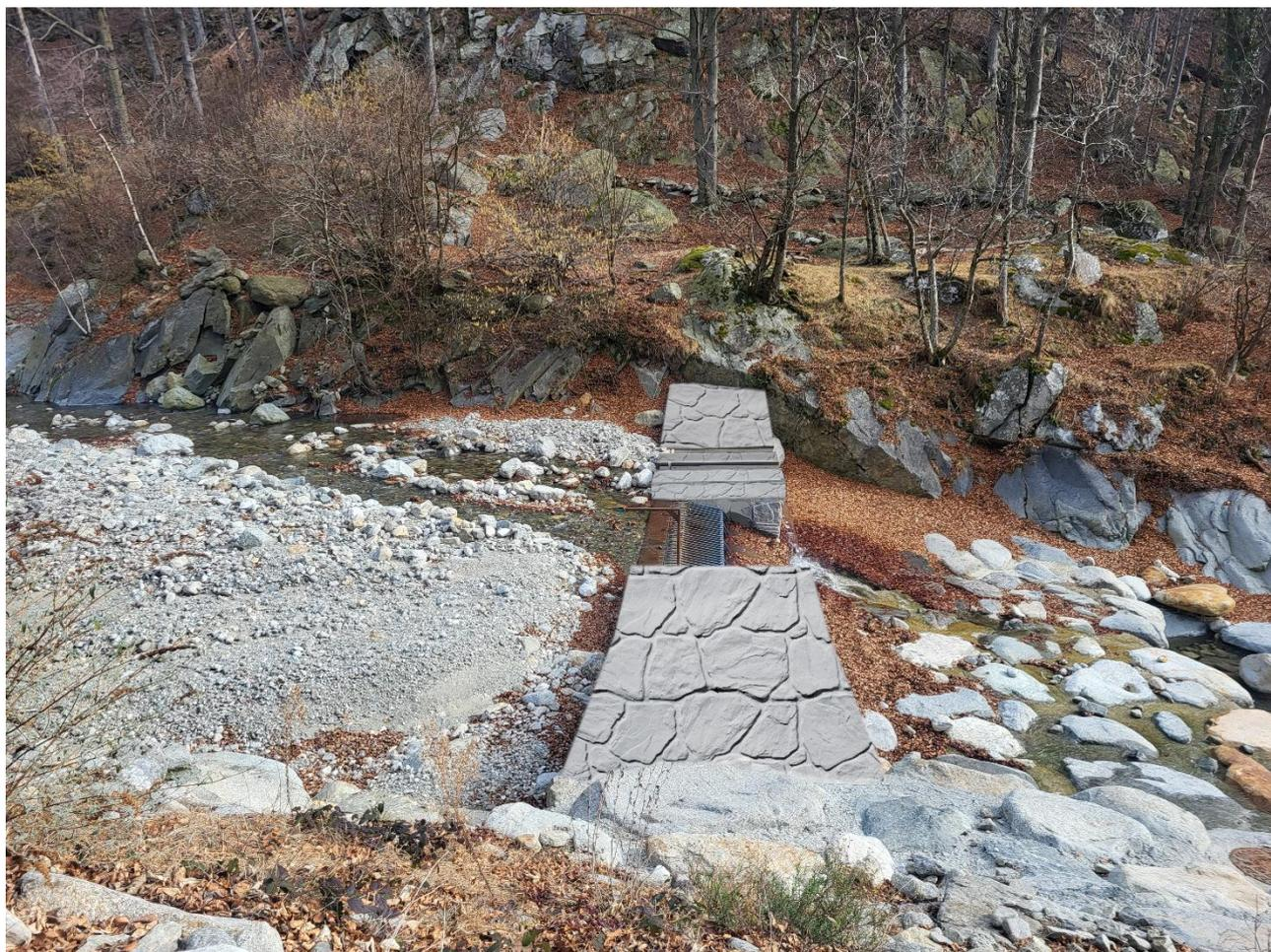
*Figura 1: Foto inserimento rivestimento traversa da pista in destra idrografica*
