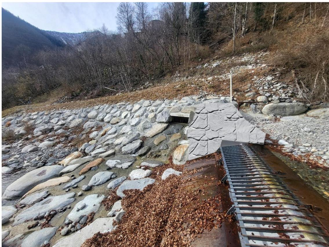
*Figura 3: Foto inserimento rivestimento traversa e posizione telecamera*
