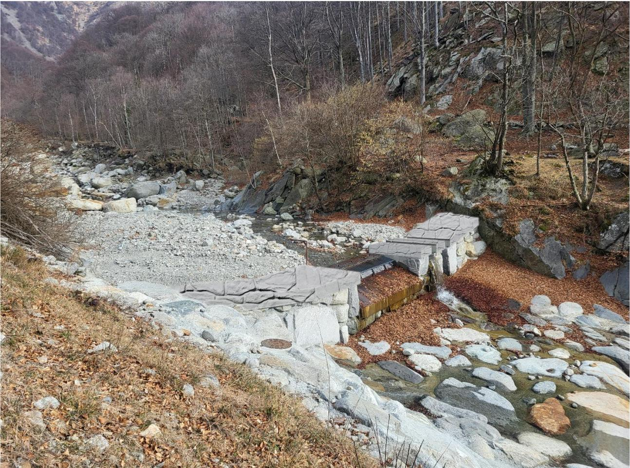
Figura 2: Foto inserimento rivestimento traversa da sponda in destra idrografica
