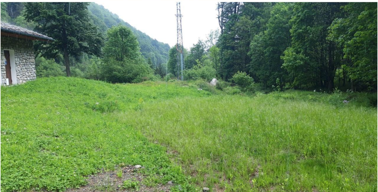
Figura 11: le azioni di inerbimento sembrano essere risultate funzionali nel favorire l'insediamento di una copertura erbosa omogenea anche nell'intorno dell'edificio di centrale.
