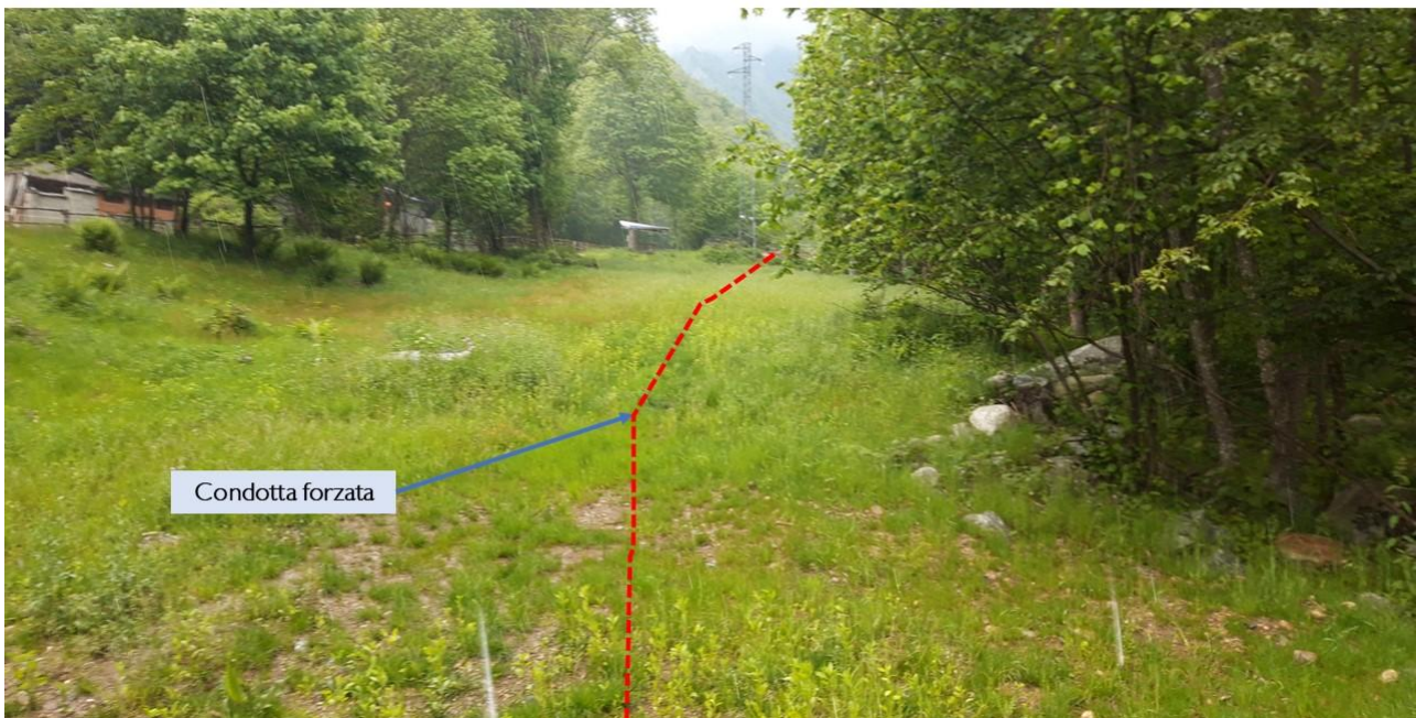
Figura 11: la porzione terminale della condotta forzata è in continuità con la parte di monte, sotto la linea dell'elettrodotto. La copertura erbacea, è ancora costituita da essenze autoctone, alle quali, in prossimità della copertura boschiva, si affiancano essenze dal carattere più nemorale, ad esempio, esemplari appartenenti alla famiglia delle Geraniaceae.
