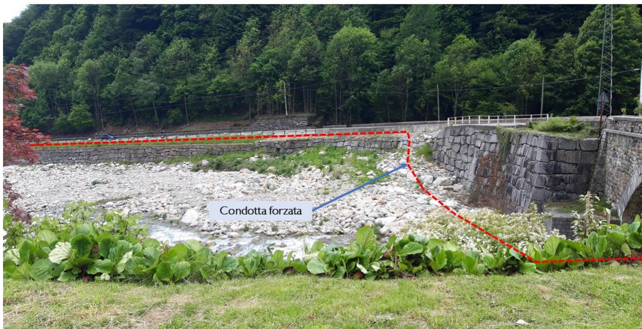
Figura 9: l'attraversamento in subalveo del torrente Cervo, non mostra evidenze di ricolonizzazione di essenze infestanti. unica differenza rispetto alla condizione progressa è l'eliminazione dei 3 esemplari di Salix alba originariamente presenti in sponda idrografica destra al margine del ponte.
