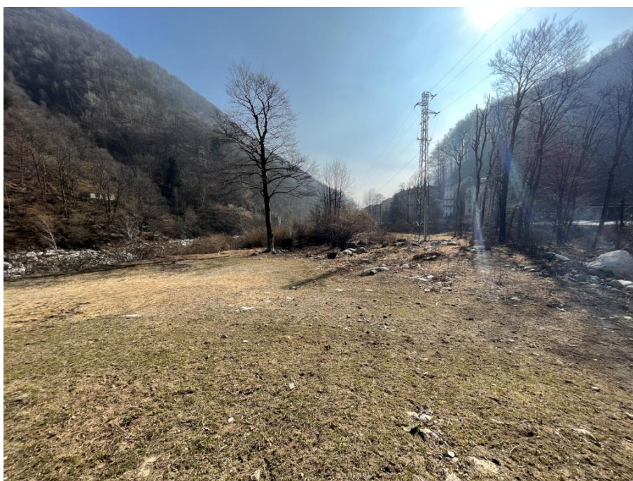
Fotografia 14: palo di sostegno della linea aerea MT presso il quale avviene la connessione tramite posa di cavo interrato (fotografia del 21/02/2023)
