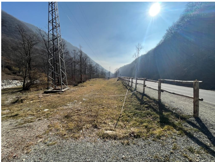
Fotografia 10: area di posa condotta fra S.P. 100 e torrente Cervo (fotografia del 21/02/2023)
