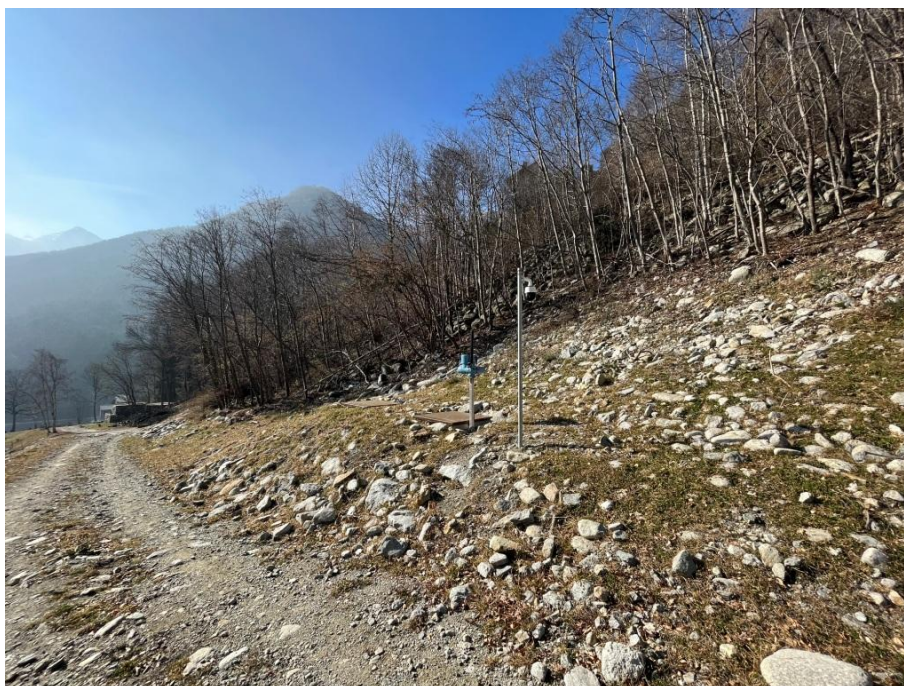
Fotografia 4: vasca dissabbiatrice / carico completamente interrata ad esclusione delle botole di accesso, stelo della paratoia e palo videocamera (fotografia del 21/02/2023)
