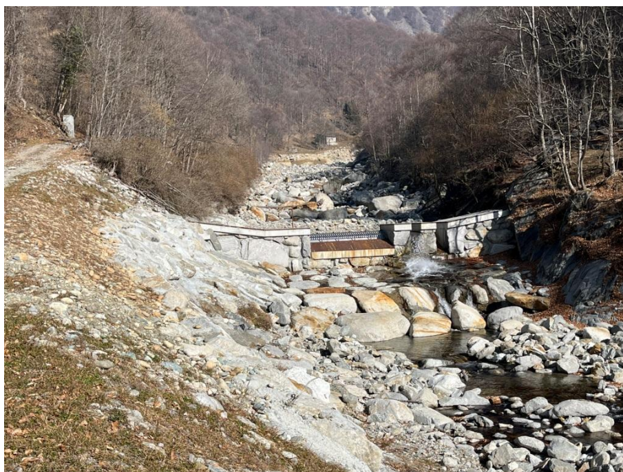
Fotografia 1: traversa di captazione (fotografia del 21/02/2023)
