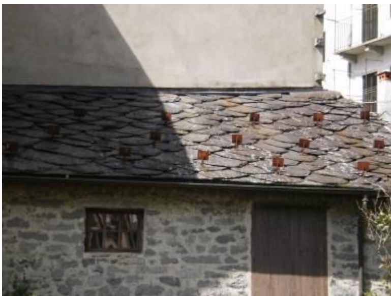
Figura 6: dettaglio di un edificio del contesto rurale: i muri in pietra (sienite) e la copertura in lose e il legno per gli altri elementi strutturali.
