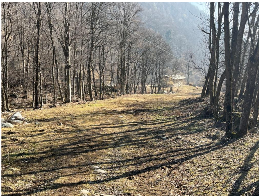
Fotografia 11: area di posa condotta al di sotto della linea aerea MT (vista verso valle) (sullo sfondo la centrale idroelettrica) (fotografia del 21/02/2023)
