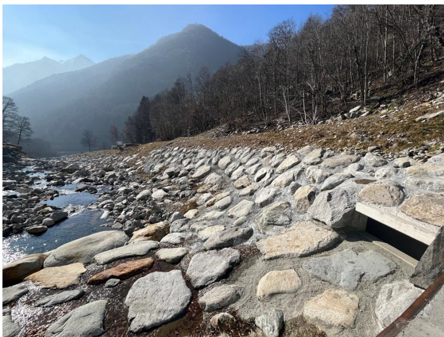
Fotografia 3: sponda destra del T. Chiobbia appena a valle della traversa di derivazione (fotografia del 21/02/2023); si noti lo sfioratore ad inizio canale di derivazione
