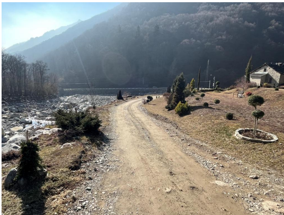
Fotografia 7: pista sterrata al di sotto della quale è posata la condotta forzata (fotografia del 21/02/2023)
