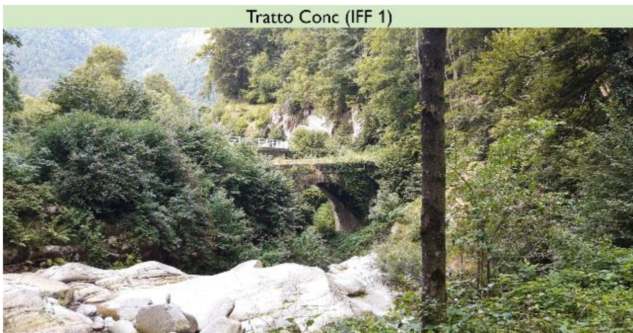
Figura 9: immagine rappresentativa del tratto Conc (IFF 1) nel tratto compreso tra i 2 ponti che lo oltrepassano.
