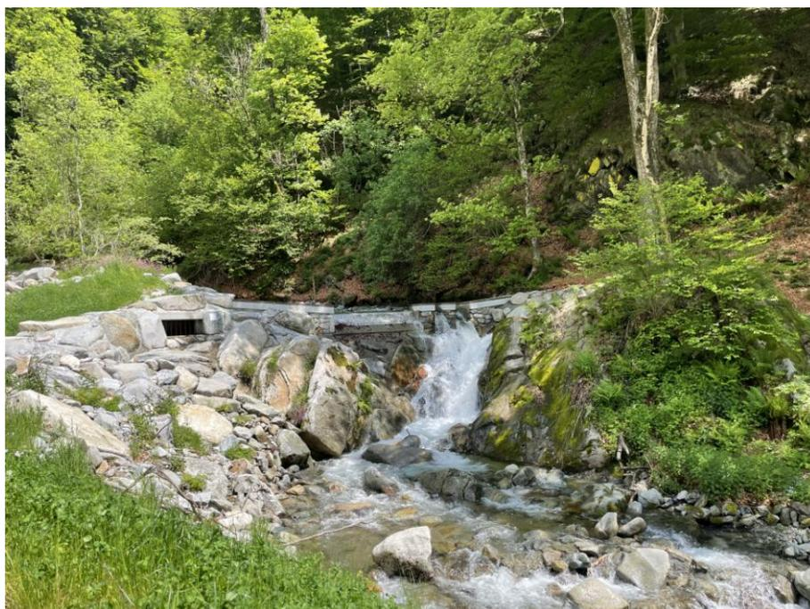
*Figura foto 2: Traversa di derivazione*
