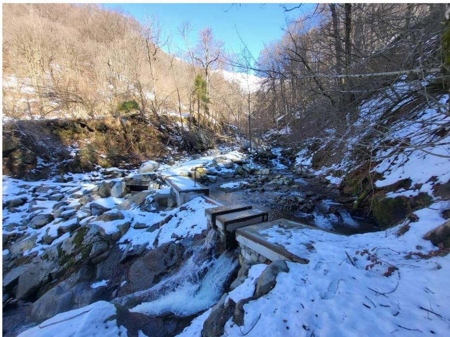
*Figura foto 9: Traversa di derivazione*
