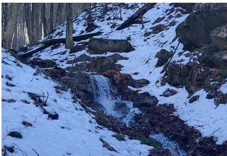
Figura 9: Vista briglia abusiva dalla destra idrografica del Torrente Concabbia
