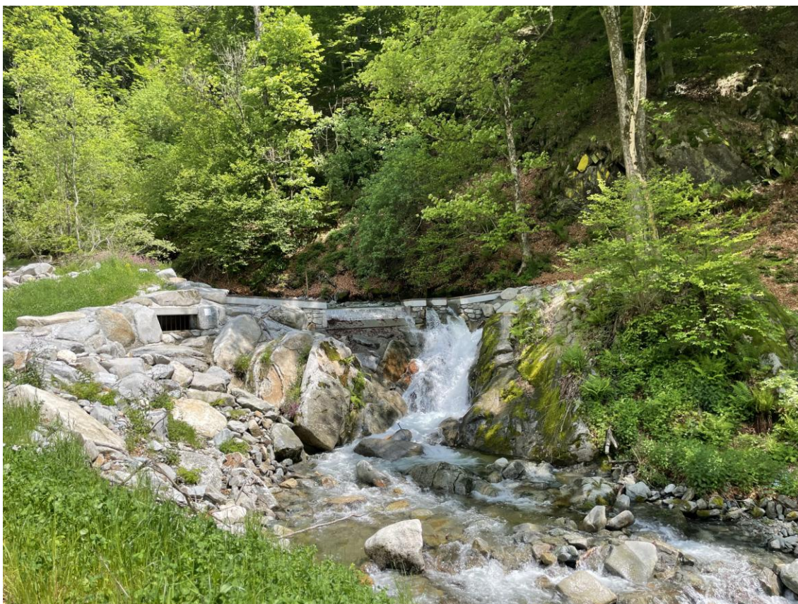
Figura foto 2: Traversa di derivazione
