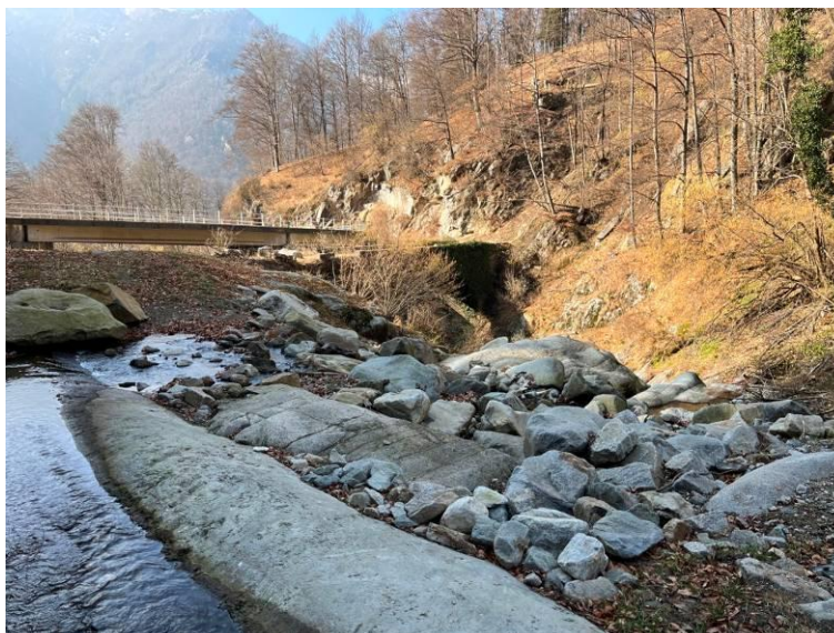
Figura 10: Attraversamento in subalveo
