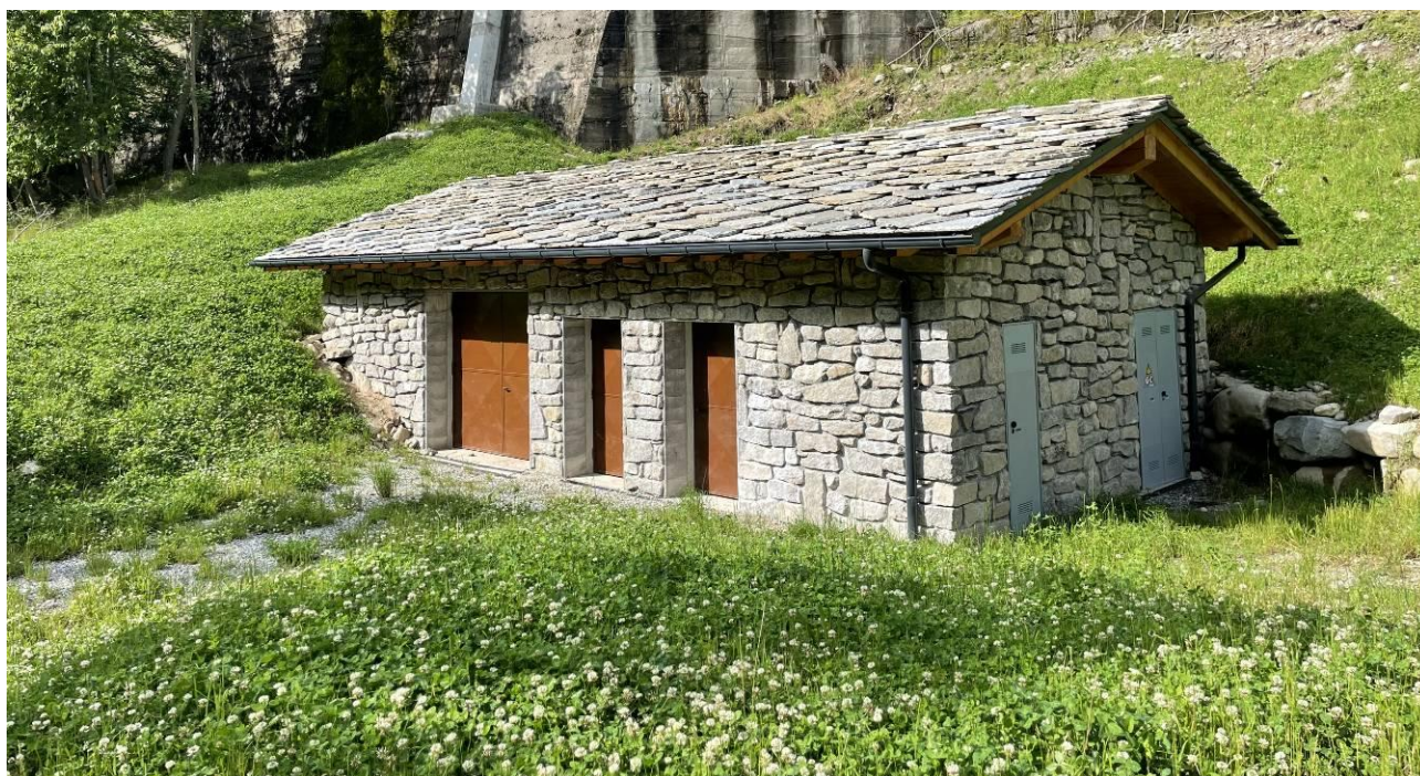
Figura foto 6: Centrale di produzione
