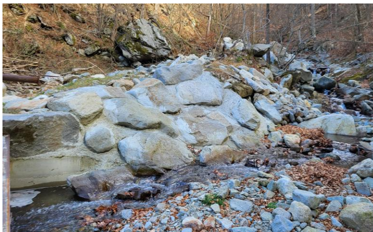
Figura 6: scogliera realizzata a monte della traversa
