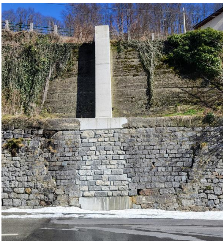
Figura 11: Tratto di condotta esterna a monte della SP100
