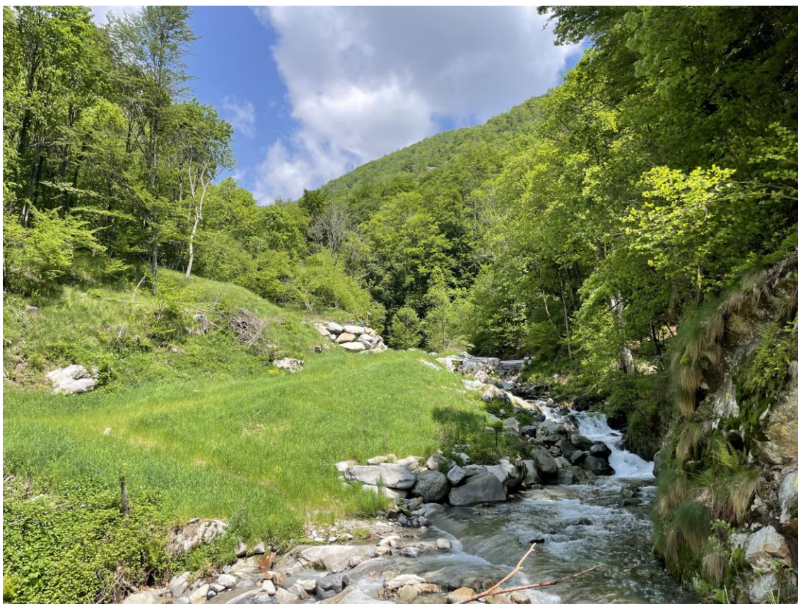
Figura foto 4: Traversa di derivazione e vasca di carico
