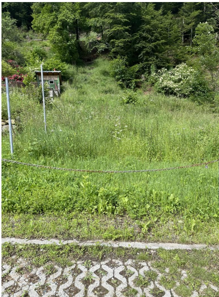
Figura foto 5: Tratto di condotta forzata lungo versante fra Forgnengo e Valmosca:
