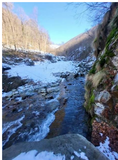
Figura 20: Stato di fatto subalveo vista da valle
