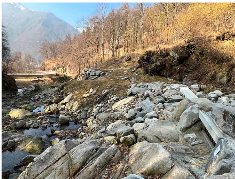
Figura 7: scogliera realizzata a valle della traversa vista dalla traversa
