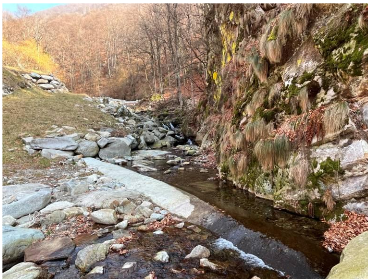
Figura 8: scogliera realizzata a valle della traversa vista dall'attraversamento; si propone di intervenire secondo quanto descritto alla questione 4 della relazione integrativa CAM_INT.01_marzo 2024 e relativa cartella Q4
