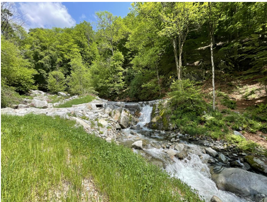
Figura foto 3: Traversa di derivazione
