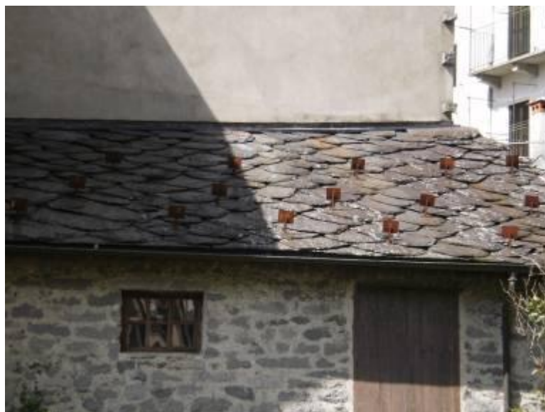
Figura 3: dettaglio di un edificio del contesto rurale: i muri in pietra (sienite) e la copertura in lose e il legno per gli altri elementi strutturali.
