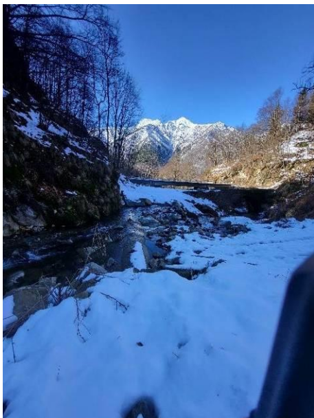
Figura 19: Stato di fatto subalveo vista da monte
