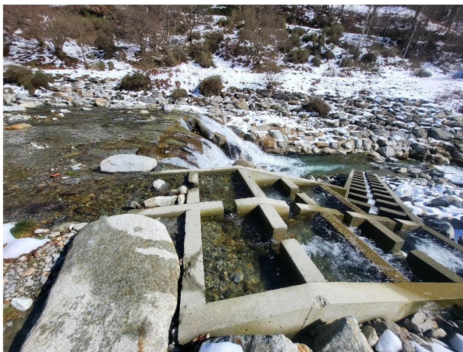
Figura 2: Vista Scala di risalita da monte verso valle
