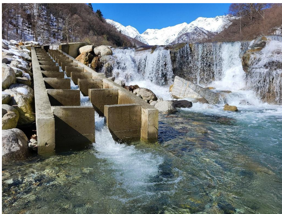
Figura 5: Vista da valle della scala di risalita
