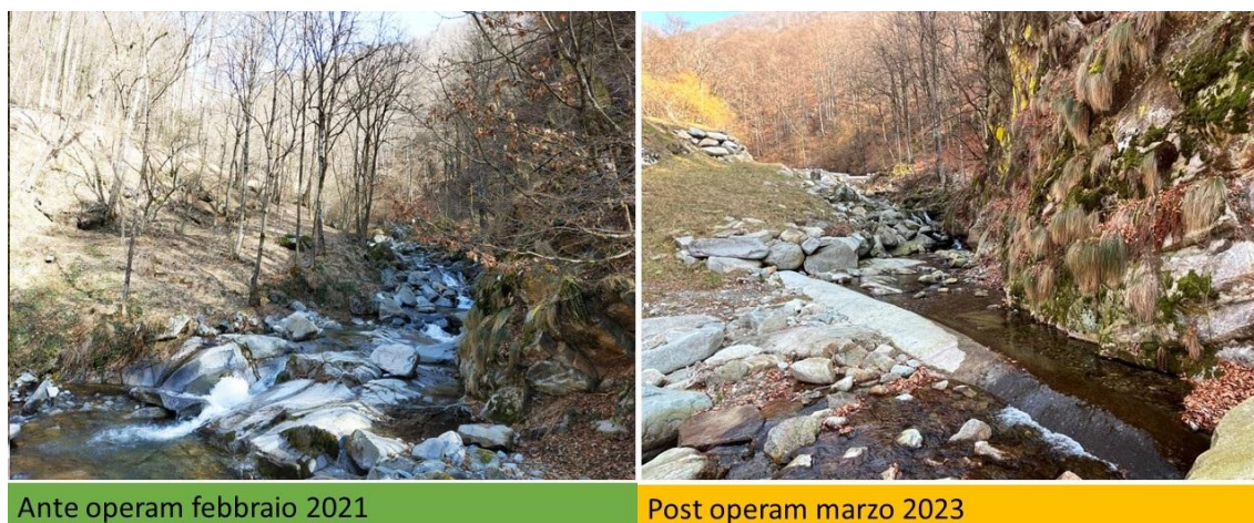
Figura 3.18: vista del tratto interessato dal passaggio della condotta in sub alveo.
