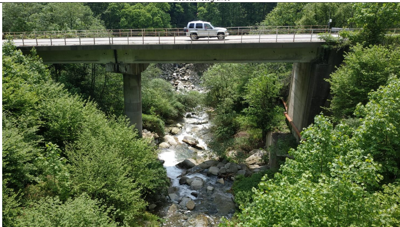
Vista della porzione terminale del tratto CB-2. Il grado di confinamento del torrente diminuisce in prossimità della confluenza. Si osservino i pilastri di sostegno della strada, che rappresentano un elemento di artificialità.
