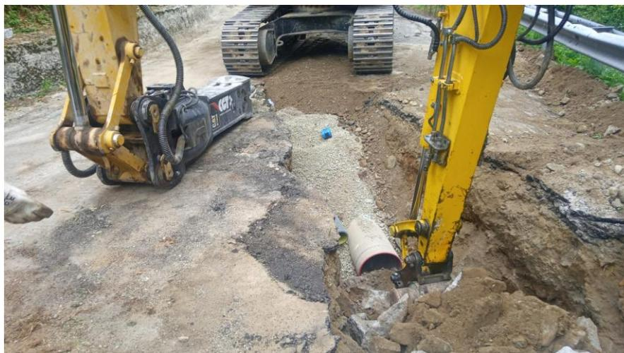
*Figura 6: Parte terminale attraversamento in diagonale SP*
