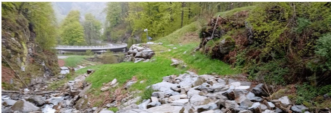
*Figura 3 - rendering ricoprimento del canale di adduzione con pietra locale (vista da monte)*
