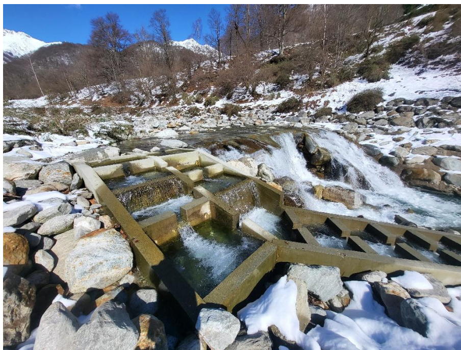
Figura 3: Vista del primo tratto di monte della scala di risalita
