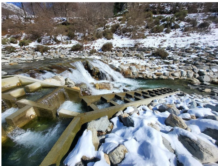
Figura 4: Vista del secondo tratto da monte della scala di risalita
