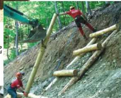
Trasporto e posizionamento dei montanti
