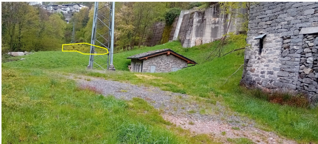
Figura 8: panoramica del sito in cui è stata inserita la centrale di produzione. È evidenziata una copertura a R. japonica a monte dell'edificio di centrale. Tale consorzio è cresciuto nella fascia di rispetto dell'elettrodotta esistente ed è indipendente dai lavori di costruzione dell'impianto.
