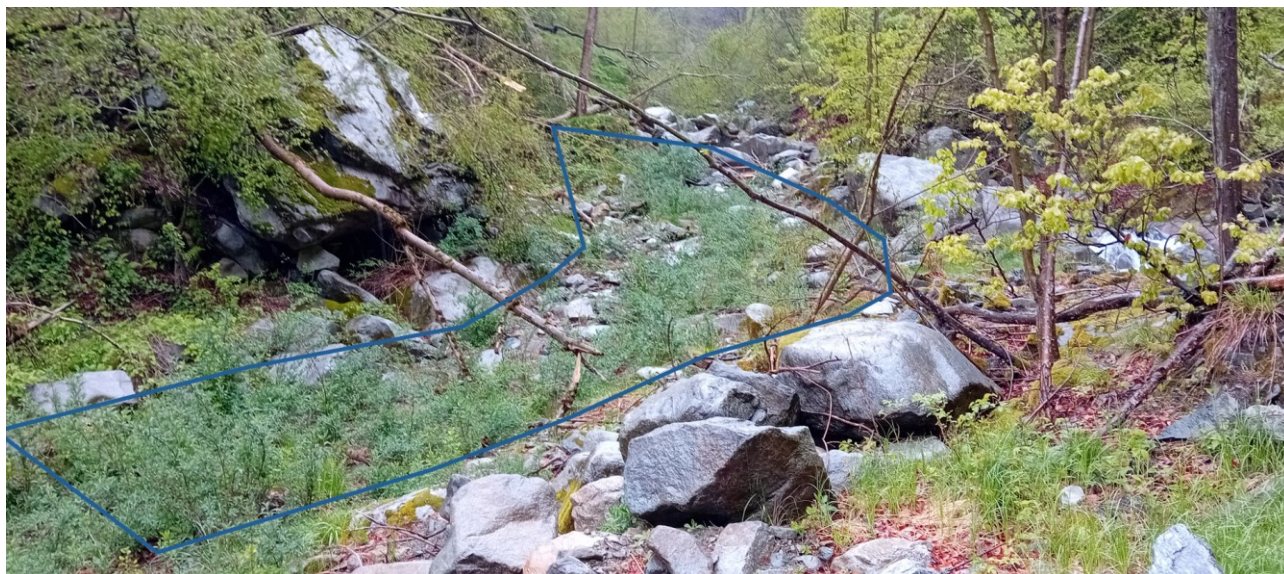
Figura 3: porzione di alveo abbandonato in sponda idrografica destra, immediatamente a monte dell'opera di presa. L'area, perturbata nel corso dei lavori è interessata da una copertura di esemplari di B. davidii .
