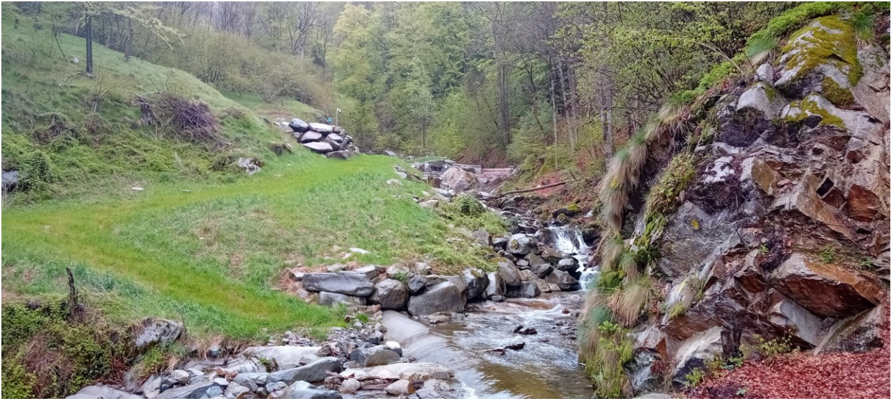
Figura 1: vista dell'opera di presa e del primo tratto di condotta a valle del dissabbiatore completamente interrato.
