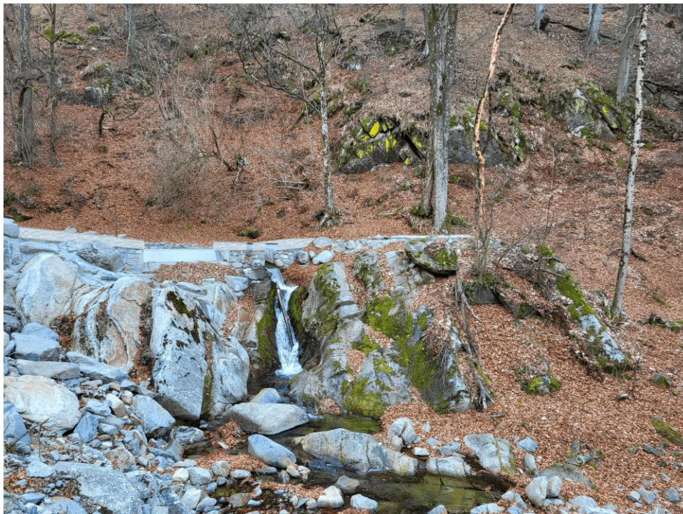
Figura 2 - rivestimento in pietra locale della presso traversa di presa (vista da valle)
