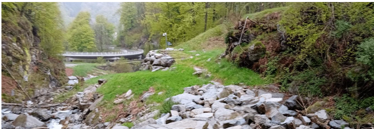
Figura 3 - ricoprimento del canale di adduzione con pietra locale (vista da monte)
