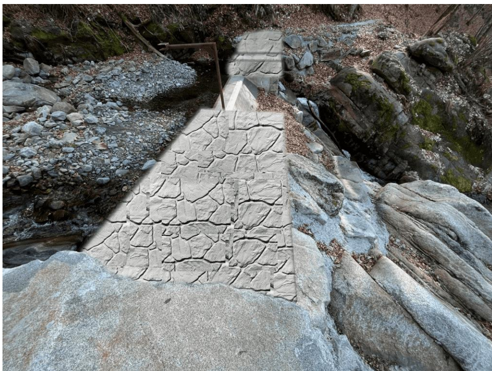
Figura 1 - rivestimento in pietra locale della presso traversa di presa (vista da sponda destra in linea con traversa)
