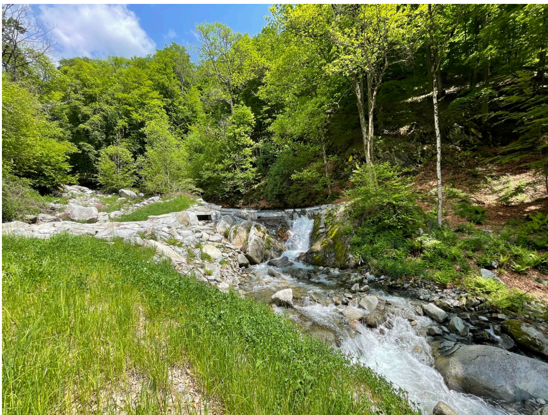
Figura foto 3: Traversa di derivazione
