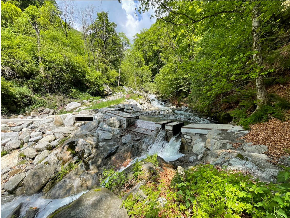
Figura foto 1: Traversa di derivazione
