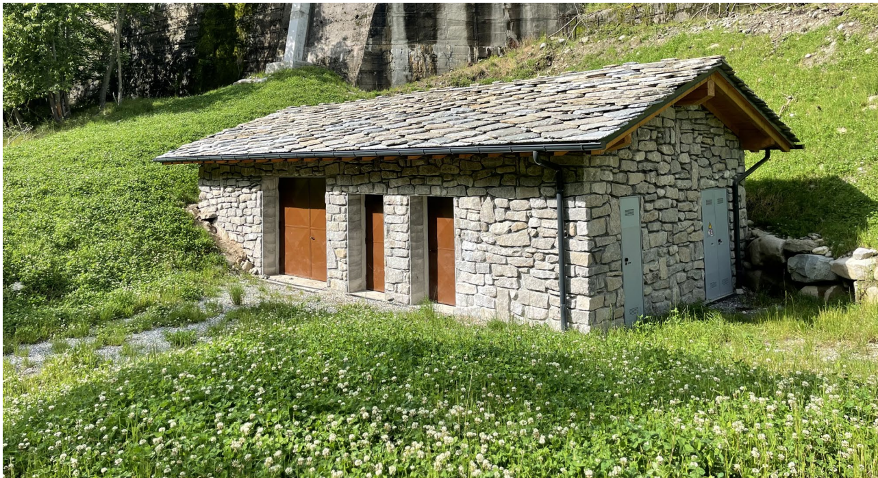
Figura foto 6: Centrale di produzione
