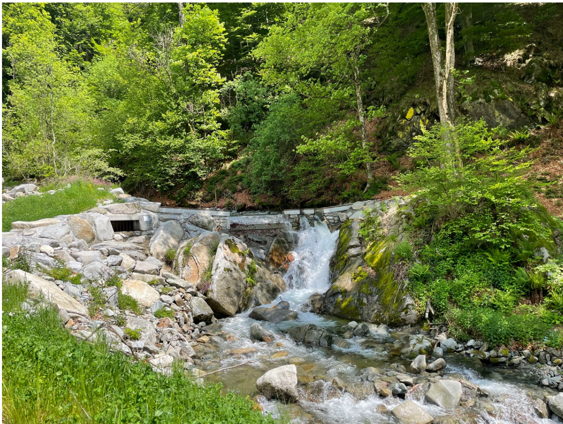
Figura foto 2: Traversa di derivazione
