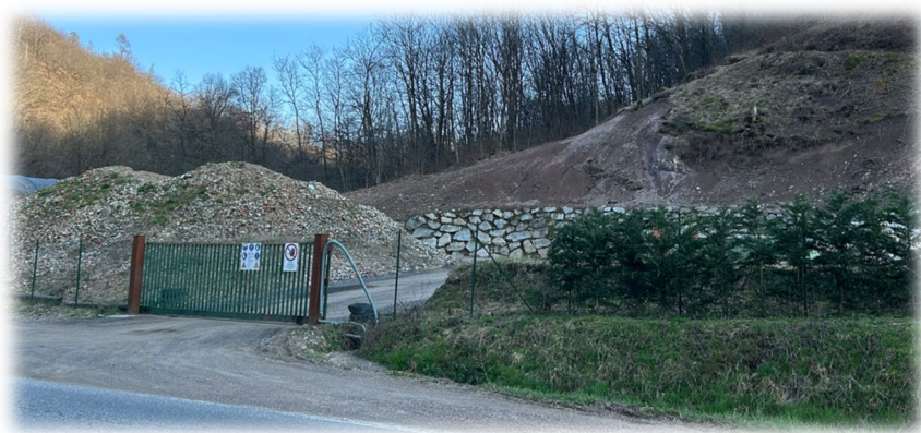
Cancello di accesso, recinzione frontale ( con quinta arborea) e scogliera posteriore
